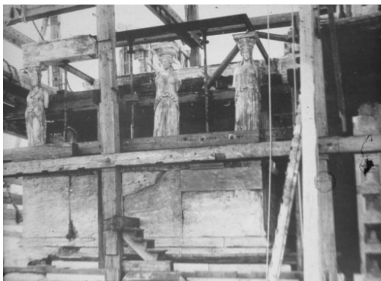
Εικόνα 2 Εργασίες στη νότια Πρόσταση κατά την αναστήλωση του Ν. Μπαλάνου
