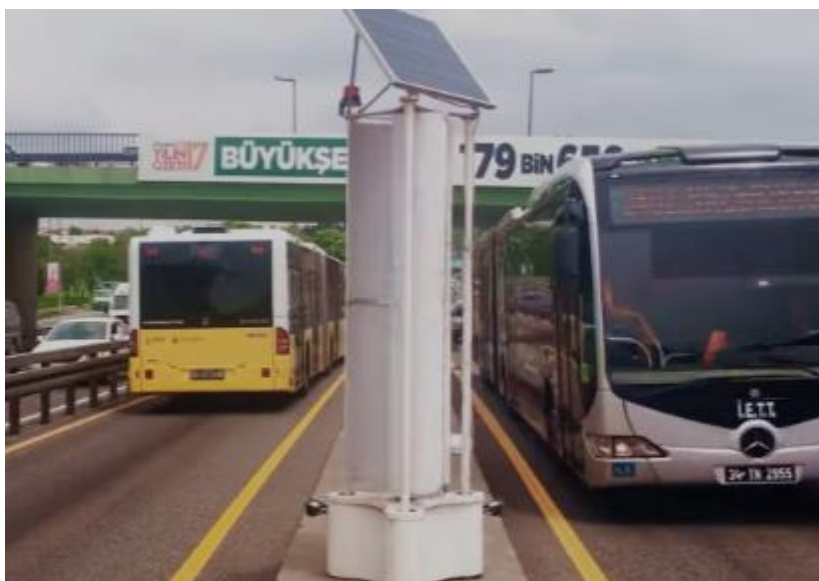
Εικόνα 4.2: Παράδειγμα στην Τουρκία με επιλεγμένο αυτοκινητόδρομο που είναι σε ισχύ οι κάθετες ανεμογεννήτριες σύμφωνα με τα οχήματα που τις διαπερνούν.
