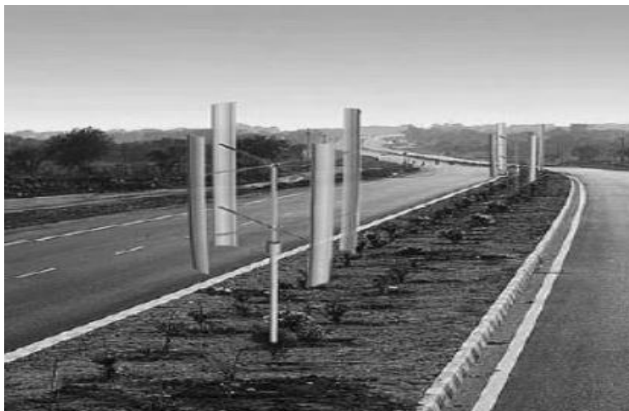
Εικόνα 4.3: Εγκατεστημένες ανεμογεννήτριες κάθετου άξονα σε κύριο δρόμο διπλής κατεύθυνσης στη Μαλαισία.
