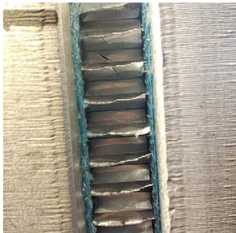
ΕΙΚΟΝΑ 4.2.4 1 Ρωγμές σε γειτονικά κελιά
