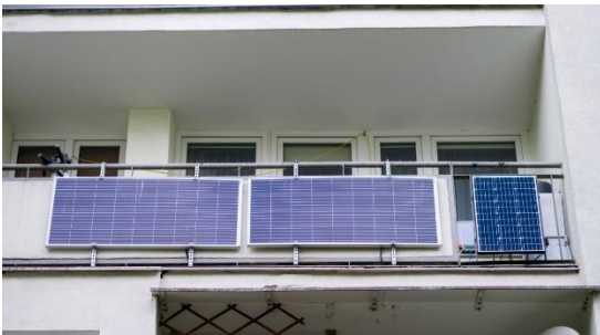
20.Κλασική λύση με κάγκελο, σε αστικό περιβάλλον, με μόνιμη στήριξη
