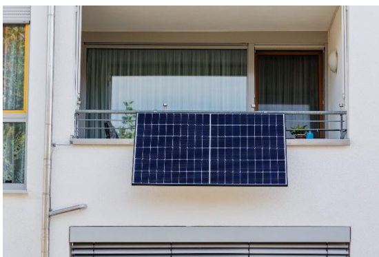
17.Plug-and-play πάνελ τοποθετημένα σε κάγκελο, έτοιμα προς χρήση χωρίς ηλεκτρολόγο
