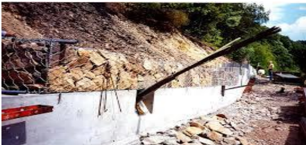
Εικόνα 20: Εγασίες σταθεροποίησης Κατολίσθησης. https://encrypted-tbn0.gstatic.com/images?q=tbn:ANd9GcTXuQLv90p3YPvALL2YcyIbOoGl4Xpkko_ymytBLtwQfyrPVUJrZyrSU8hR_xvBDFM2E34&usqp=CAU
