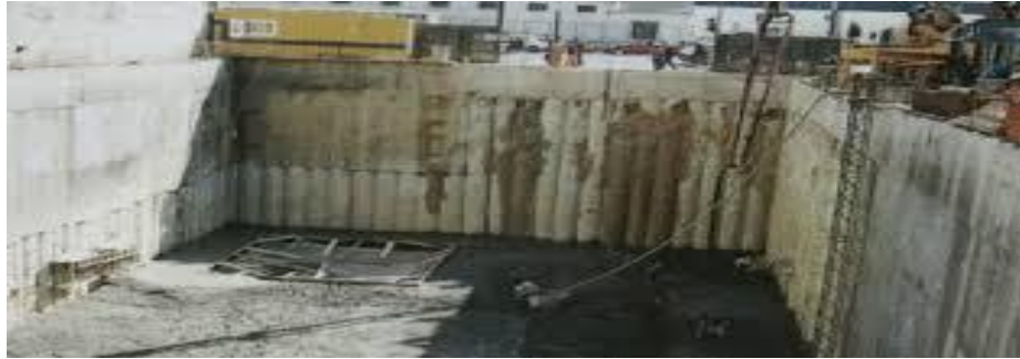
Εικόνα 23: Πασσαλότοιχος εφαπτόμενων πασσάλων.
