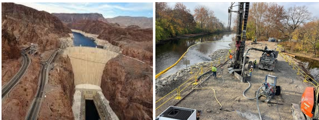
Εικόνα 31: Φράγμα Hoover ΗΠΑ - Χρήση τεχνικής Jet grouting. https://www.schnabel.com/wp-content/uploads/2024/03/Jet-Grouting-Operation-in-Lower-Olentangy-Tunnel-Project-1024x768.jpeg https://energypress.gr/sites/default/files/article/images/fragma_hoover.jpg
