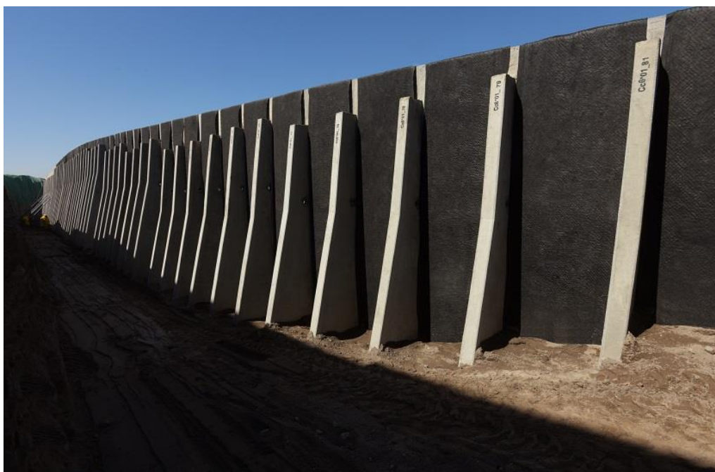
Εικόνα 3: Τοίχοι με Αντηρίδες. https://www.geoquest-group.com/wp-content/uploads/sites/20/2019/11/TechWall2-800x535.jpg
