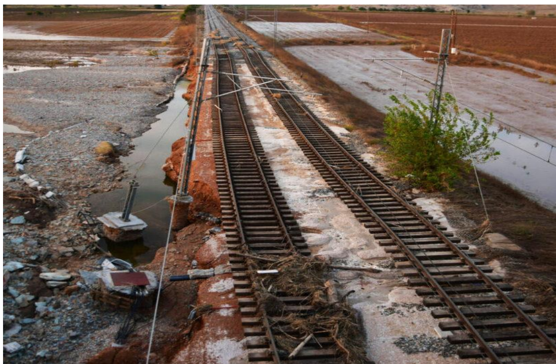
Εικόνα 25: Σιδηροδρομικό δίκτυο Θεσσαλίας που επλήγη από τις πλημμύρες.
