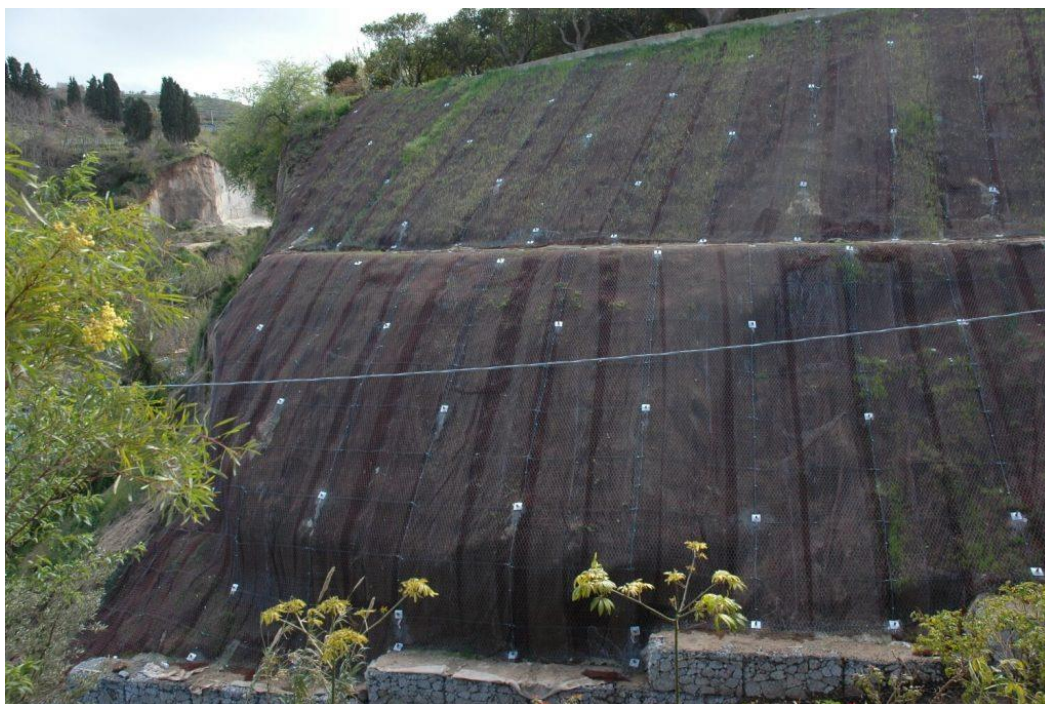
Εικόνα 17: Χρήση τεχνικής soil nailing (Καρφιά εδάφους).
