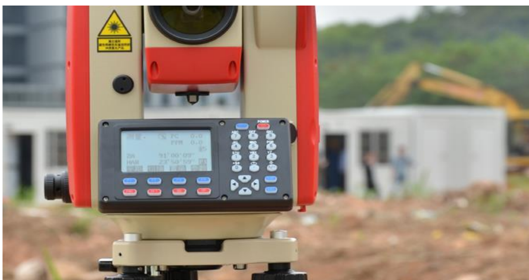
Εικόνα 18: Γεωδαιτικός Σταθμός παρακολούθησης.
