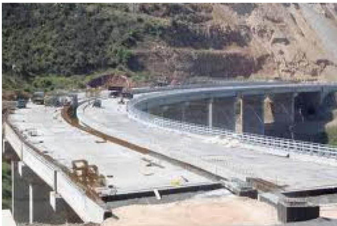
Εικόνα 35: Τοποθέτηση πασσαλότοιχων, για την αντιμετώπιση κατολισθήσεων.
