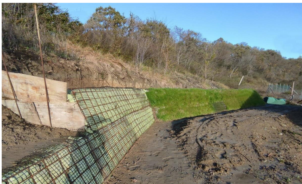
Εικόνα 22: Βελτίωση πρανών και προστασία από την έκπλυση του εδάφους.
