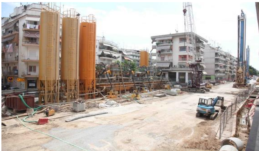
Εικόνα 34: Μετρό Θεσσαλονίκης, τεχνική θεμελίωσης jet grouting.
