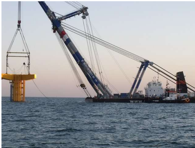
Εικόνα 5.4: Λήψη καθέλκυσης του πασσάλου θεμελίωσης (Monopile)
