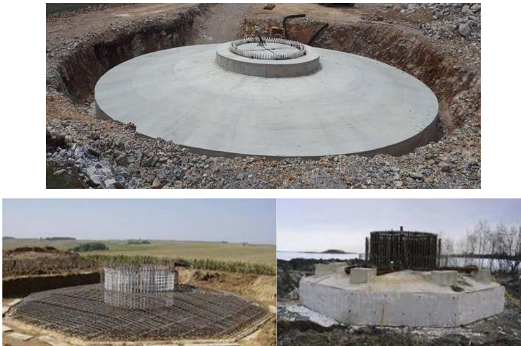
Εικόνα 2.5: Λήψεις εφαρμογής στο πεδίο των διαφορετικών επιλογών θεμελίωσης μιας χερσαίας Α/Γ
