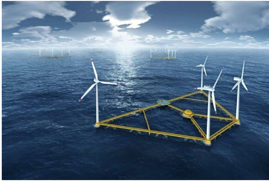
Εικόνα 3.7: Τοποθέτηση Α/Γ σε πλωτή πλατφόρμα, η οποία στη συνέχεια στερεώνεται στον πυθμένα με καλώδια πρόσδεσης και ειδικά άγκιστρα
