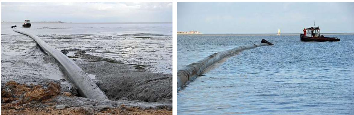
Εικόνα 5.6: Λήψεις από τα διαφορετικά στάδια εγκατάστασης των καλωδίων Export στη λασπώδη περιοχή και στην ανοιχτή θάλασσα
