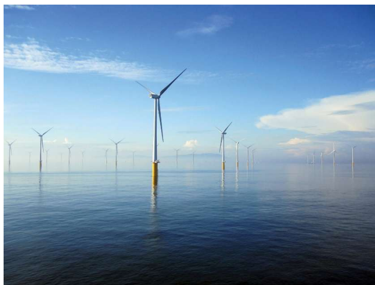
Εικόνα 5.3: Λήψη των Α/Γ του London Array, διακρίνεται το κίτρινο μεταβατικό τμήμα
