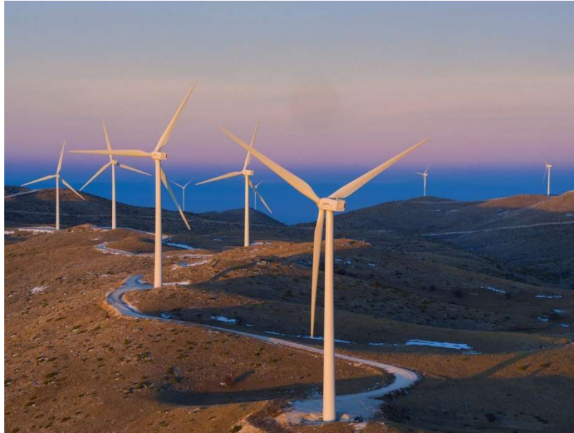
Εικόνα 3.4: Παράκτιο πάρκο ισχύος 36 MW στη θέση Ερεσού ύψωμα Φούρκα Κεντρικής Μακεδονίας με 18 Α/Γ τύπου Gamesa G114 και έναρξη λειτουργίας το 2018
