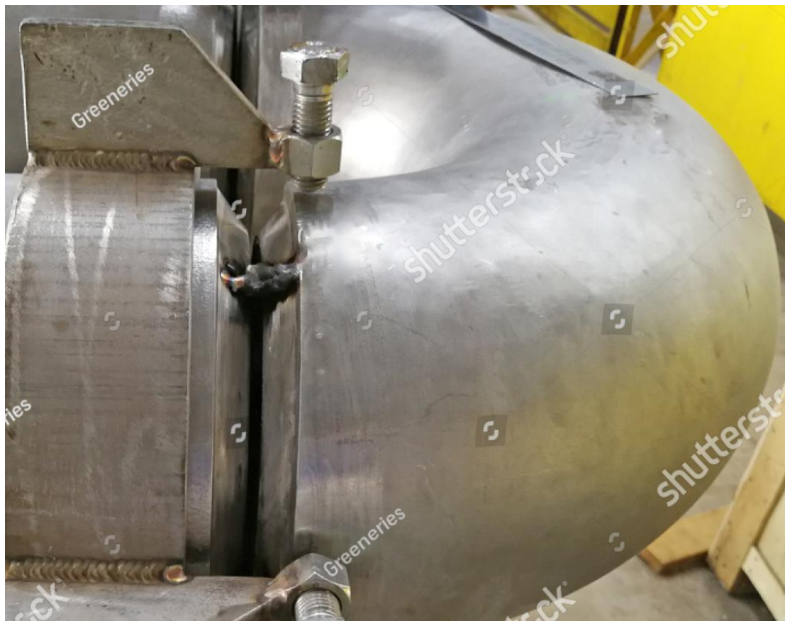
Εικόνα 11: Ευθυγράμμιση Σωλήνων Πριν την Κοληση
