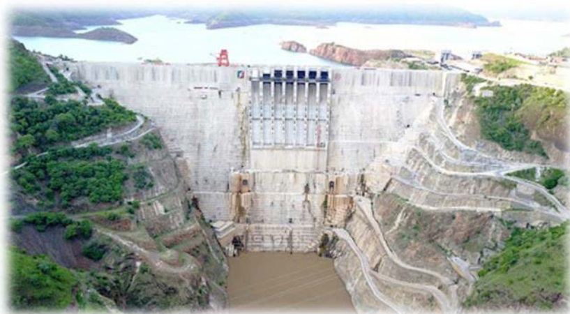
Εικόνα 16: Φράγμα Gibe III (Αιθιοπία)
