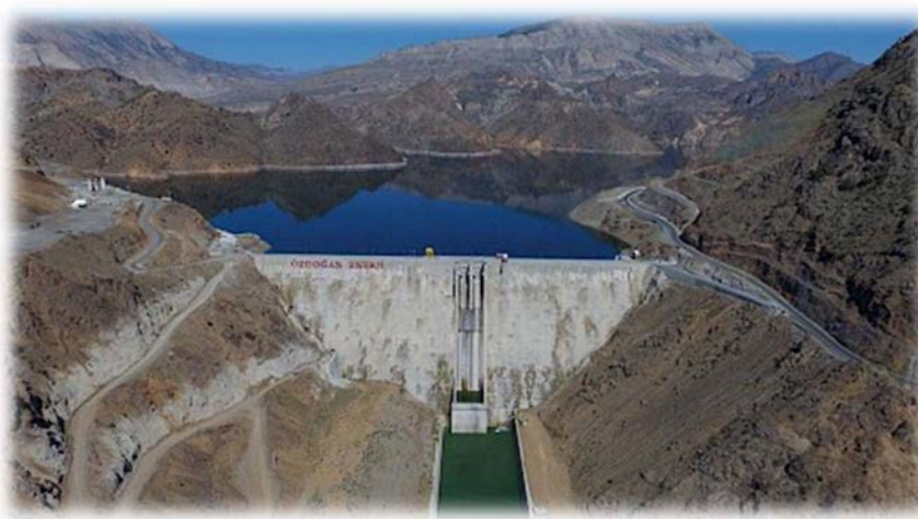
Εικόνα 21: Φράγμα Ayvali (Τουρκία)
