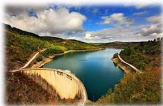
Εικόνα 8: Το φράγμα του Ταυρωπού
