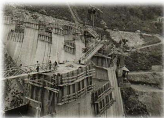
Εικόνα 9: Κατά τη κατασκευή του φράγματος
