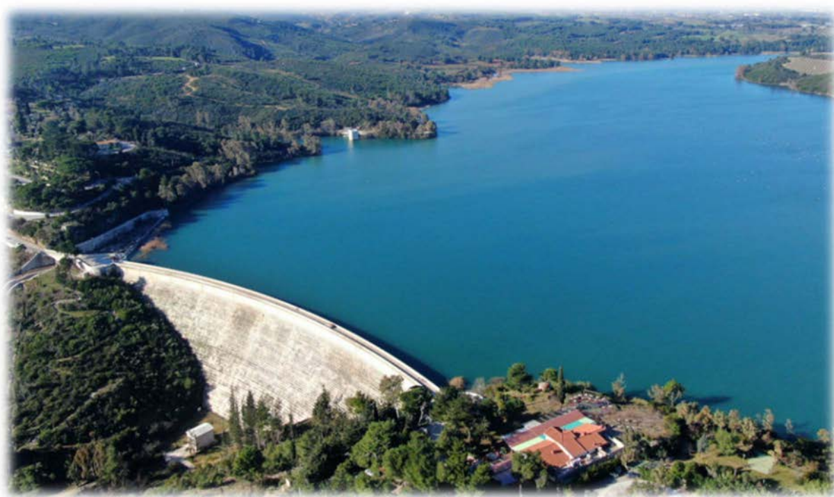
Εικόνα 6: Το φράγμα Μαραθώνα
