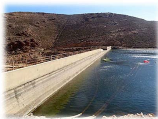
Εικόνα 24: Φράγμα Άνω Μεράς
