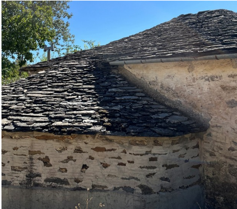
Εικόνα 22 : Παραδοσιακό σπίτι με φυσικά κονιάματα από άσβεστο. (φωτογραφία Ανδριάνα Παρθένη)
