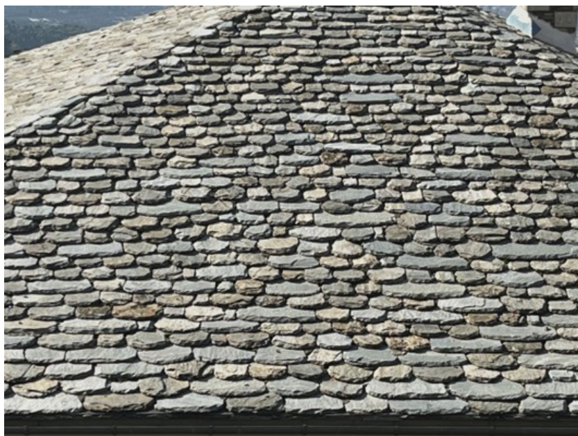
Εικόνα 21: Στέγη από σχιστόλιθο (φωτογραφία Ανδριάνα Παρθένη)
