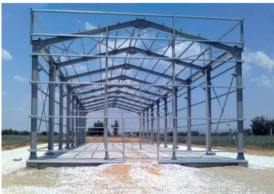
Εικόνα 40: Μεταλλικός σκελετός κτιρίου
