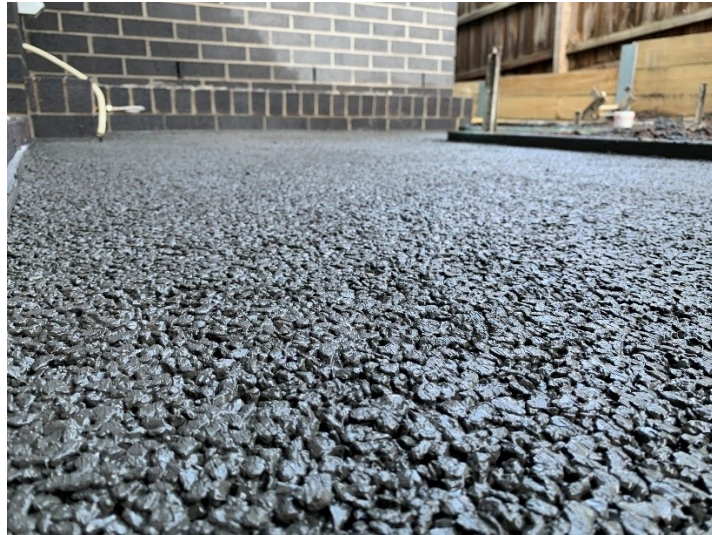
Σχήμα1: Σκυρόδεμα (Εργοταξιακά Θέματα, 2023)
