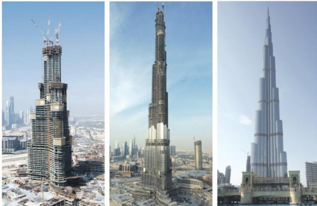
Εικόνα 8: Ο ουρανοξύστης Burj Khalifa, όπου χρησιμοποιήθηκε σκυρόδεμα με υψηλό ποσοστό ιπτάμενης τέφρας για μείωση θερμότητας ενυδάτωσης και αυξημένη αντοχή.
