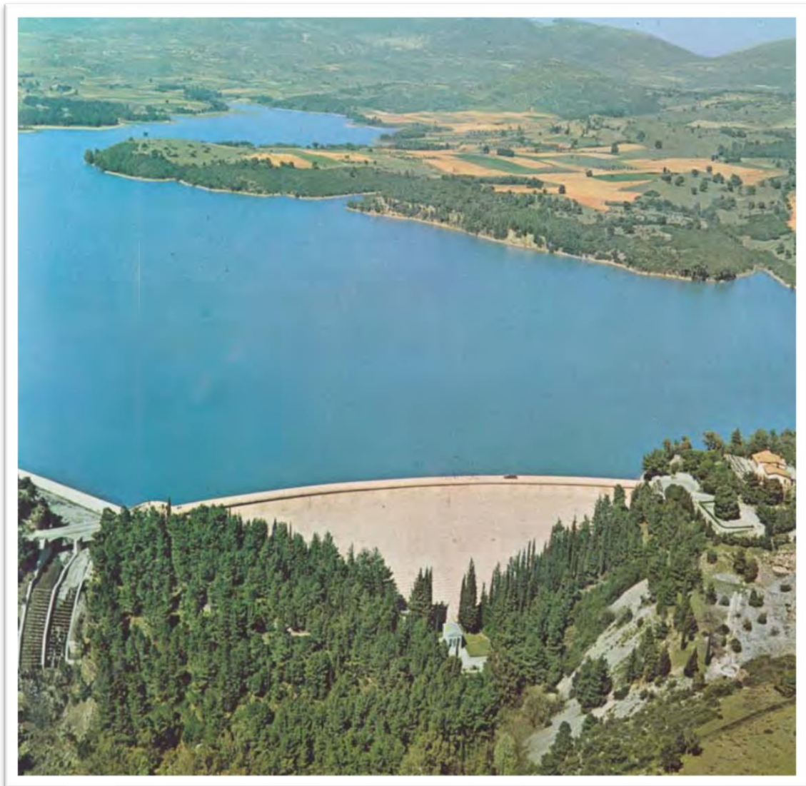
Εικόνα 10: Φράγμα Μαραθώνα (πηγή: Ελληνική Επιτροπή Μεγάλων Φραγμάτων).
