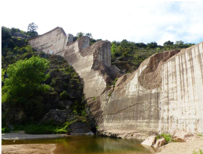
Εικόνα 22: Αστοχία Φράγματος Malpasset - Γαλλία (1959) (πηγή: eclass.upatras.gr).
