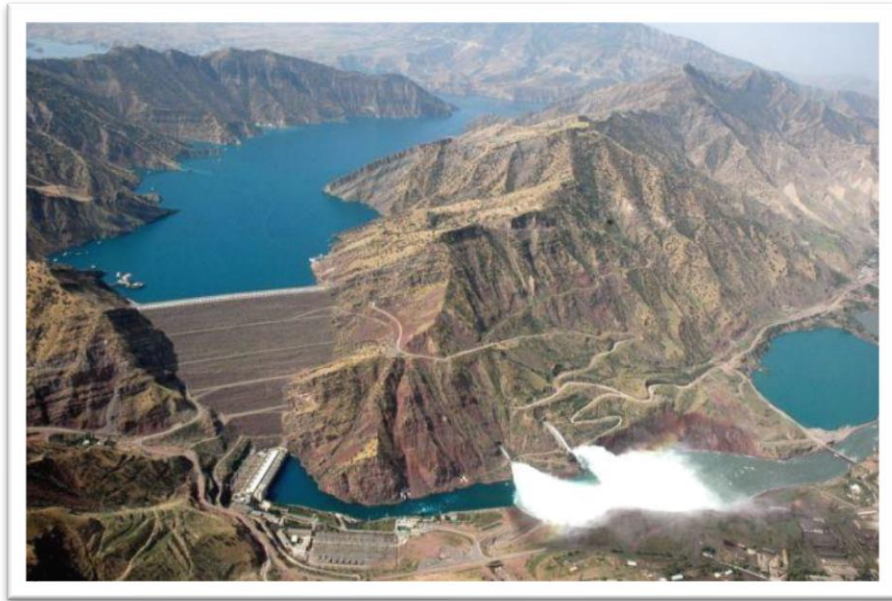
Εικόνα 19: Φράγμα Nurek (πηγή: eclass.upatras.gr).
