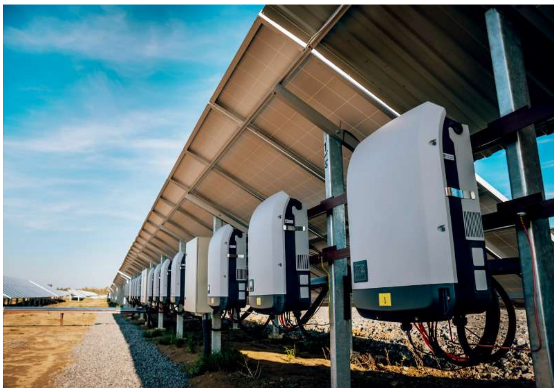
Εικόνα 11. Σύγχρονα string inverters εγκατεστημένα σε φωτοβολταϊκό πάρκο μεγάλης κλίμακας. Κάθε μονάδα διαχειρίζεται μια ομάδα πάνελ (string), μετατρέποντας συνεχές ρεύμα (DC) σε εναλλασσόμενο (AC) για σύνδεση στο Δίκτυο. Αυτά τα συστήματα παρέχουν ευελιξία, βελτιωμένη απόδοση σε καταστάσεις με μερική σκίαση και ευκολία συντήρησης.
