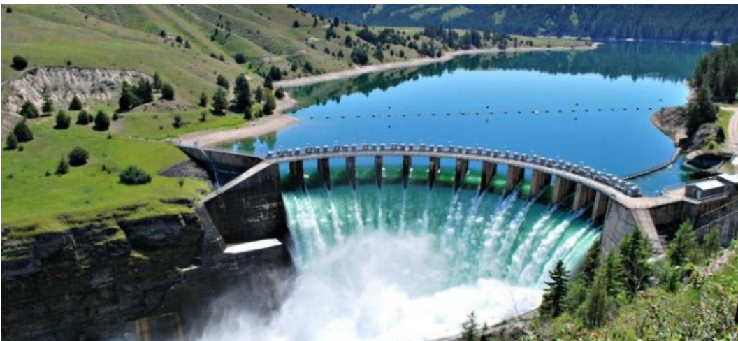
Εικόνα 5 Υδροηλεκτρικός σταθμός. (Πηγή: [5])
