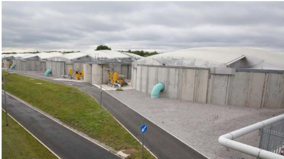
Εικόνα 12.: Primary settlement tank arrangement
