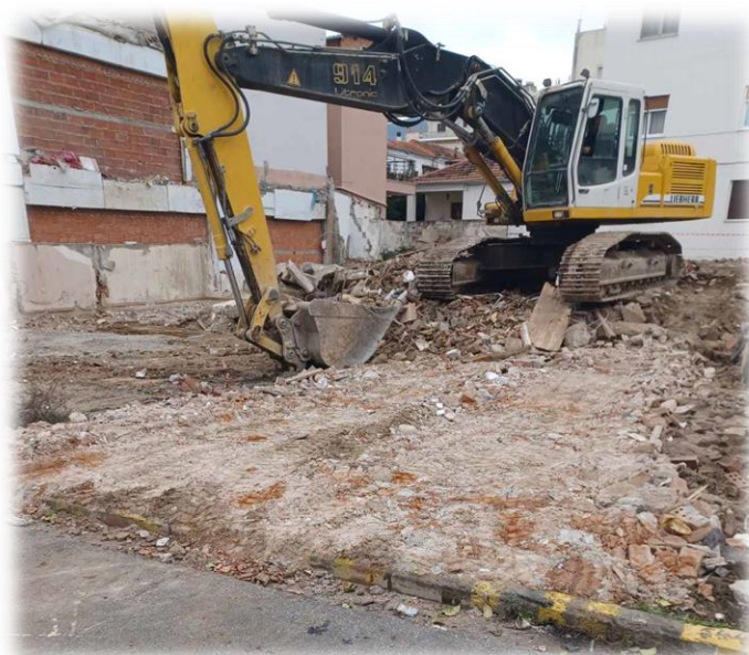
Εικόνα 2: Εργασίες ανέγερσης οικοδομής
