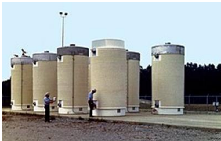
Εικόνα 26: Βαρέλια ξηράς αποθήκευσης ράβδων αναλωμένου καυσίμου
