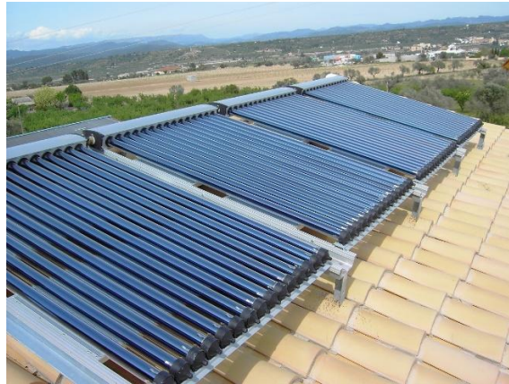
Εικόνα 2-24 Ηλιακός θερμοσίφωνας – συλλέκτες κενού [64]
