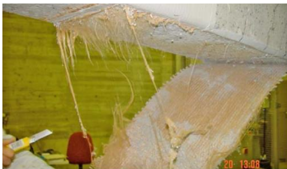
Εικόνα 9 :Αστοχία ΙΑΜ, 2 στρώσεις PBO
