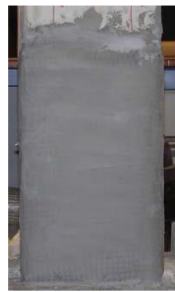
Εικόνα 8 : Τελική επικάλυψη με τσιμεντοκονίαμα
