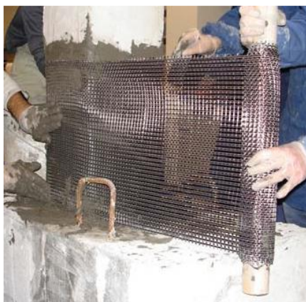
Εικόνα 7 : Ανάπτυξη ινοπλέγματος
