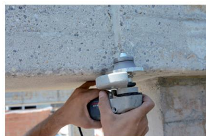
Εικόνα 5 : Ομαλοποίηση γωνιών
