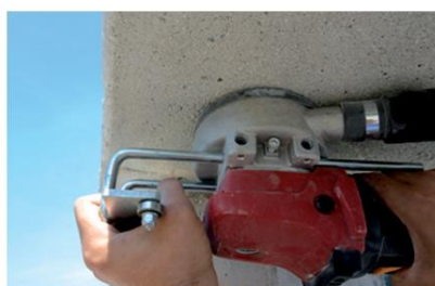
Εικόνα 4 : Εξασφάλιση απαιτούμενης τραχύτητας
