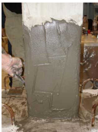
Εικόνα 6 : Επικάλυψη με τσιμεντοκονίαμα
