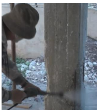
Εικόνα 3 : Καθαρισμός επιφάνειας
