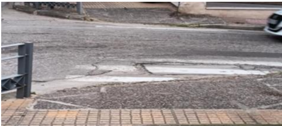
Εικόνα 48: Σκάφες σύνδεσης στην διασταύρωση με την οδό Λειβαδίτου Τάσου.
