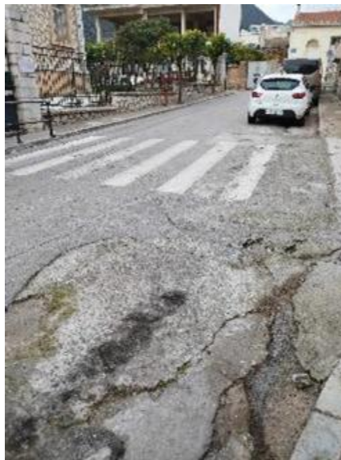
Εικόνα 19: Διάβαση στην οδό Λιανοπούλου έξω από τον χώρο του σχολείου.
