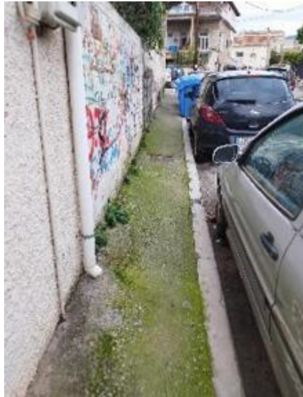
Εικόνα 18: Φύτευση στο πεζοδρόμιο της οδού
