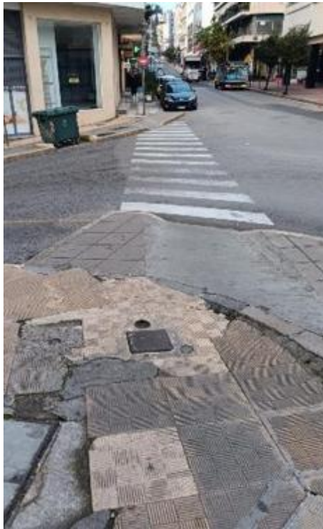
Εικόνα 56: Σκάφες σύνδεσης στην διασταύρωση με την οδό Θερμοπυλών.
