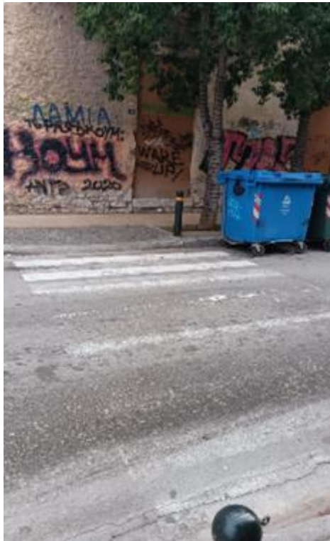
Εικόνα 46:Διάβαση οδού Όθωνος.
