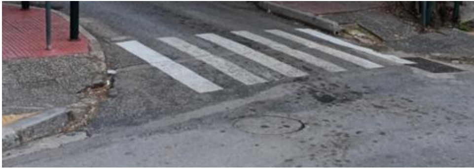
Εικόνα 47: Σκάφες σύνδεσης στην διασταύρωση με την οδό Αγίου Νικολάου.
