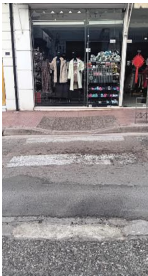
Εικόνα 64: Διάβαση οδού Κολοκοτρώνη
