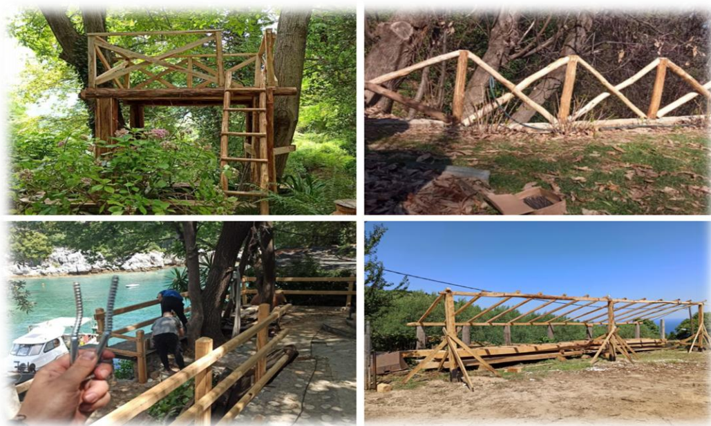
Εικόνες 43-46. Ενδεικτικές κατασκευές – δομικές κατασκευές (δεντρόσπιτο, περίφραξη, κάγκελα, υπόστεγο)
