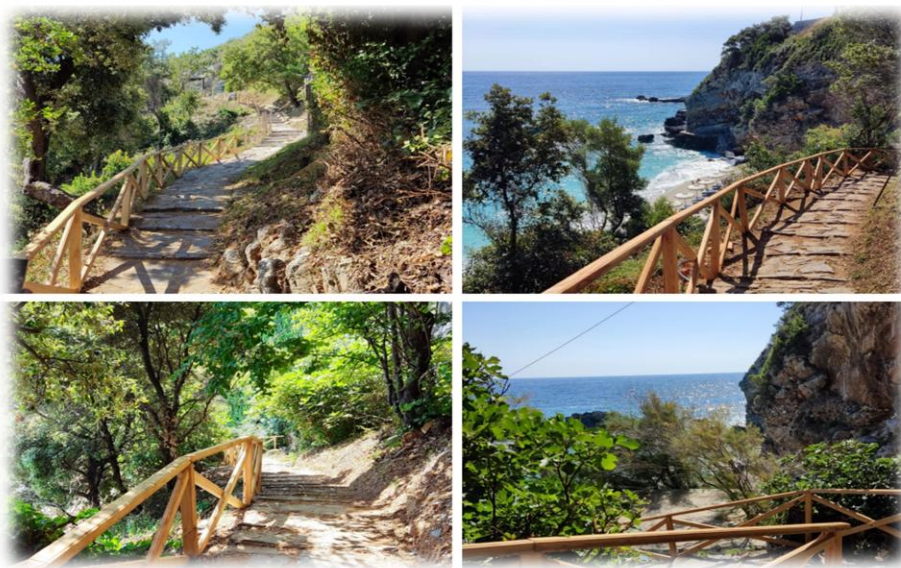
Εικόνες 47-50. Περίφραξη 100 μ. από ξύλο καστανιάς Πηλίου στην παραλία “Μυλοπόταμος” στο Πήλιο
