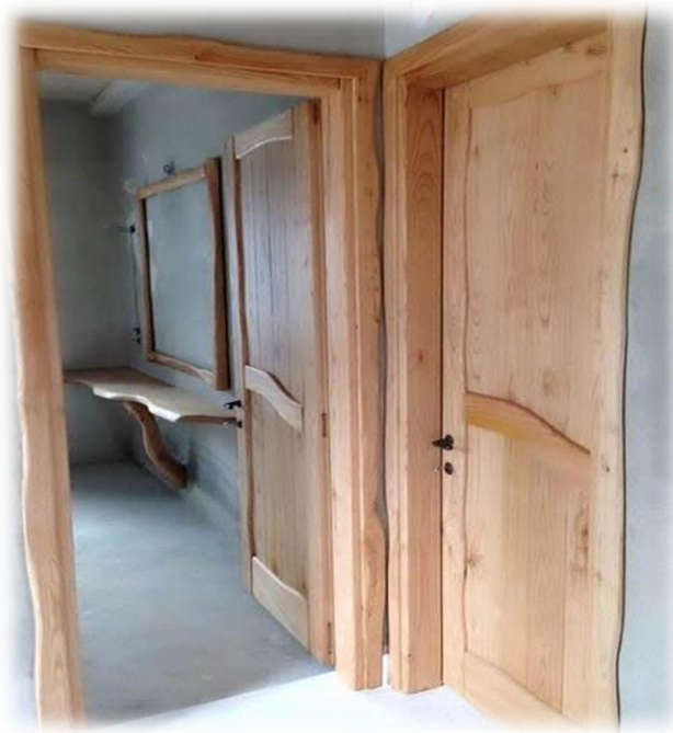
Εικόνα 8. Ξύλινες εσωτερικές πόρτες καστανιάς και επενδύσεις
