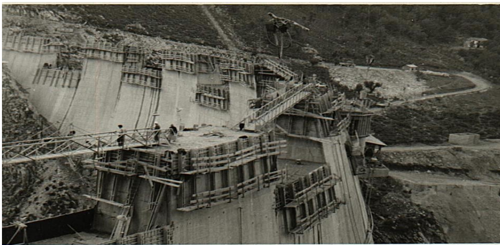
Εικόνα 7. Η κατασκευή του φράγματος (plastiras-ota.gr)
