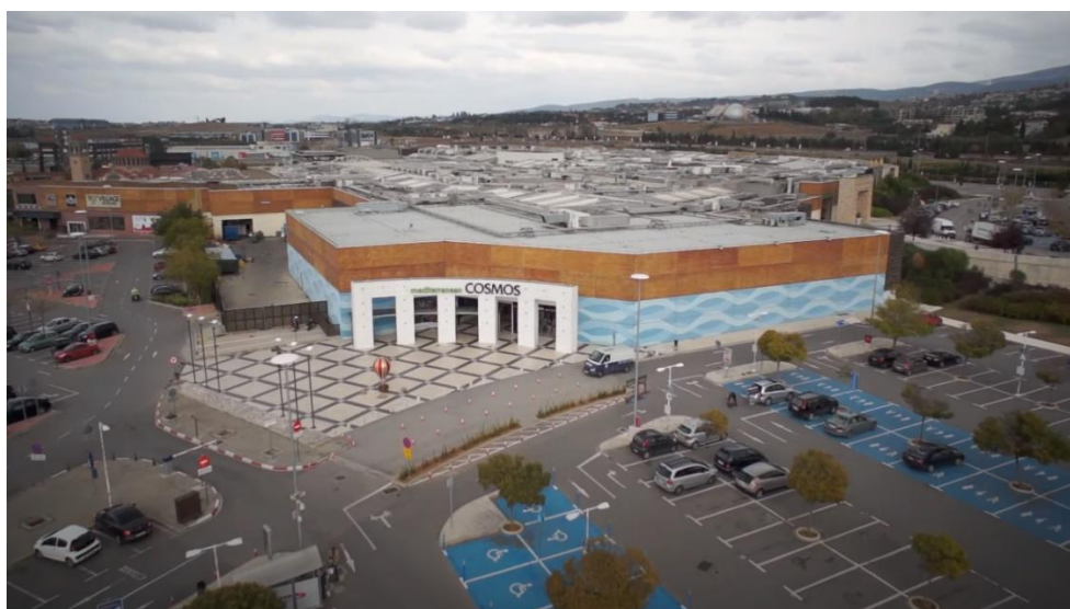
Εικόνα 5: Χώρος στάθμευσης του Mediterranean Cosmos (LAMDA Development, 2025)
