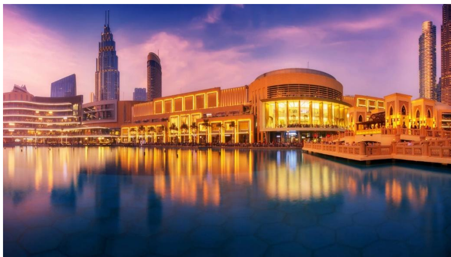
Εικόνα 16: Εξωτερικός χώρος στο Dubai mall (Dubai Mall, 2023)
