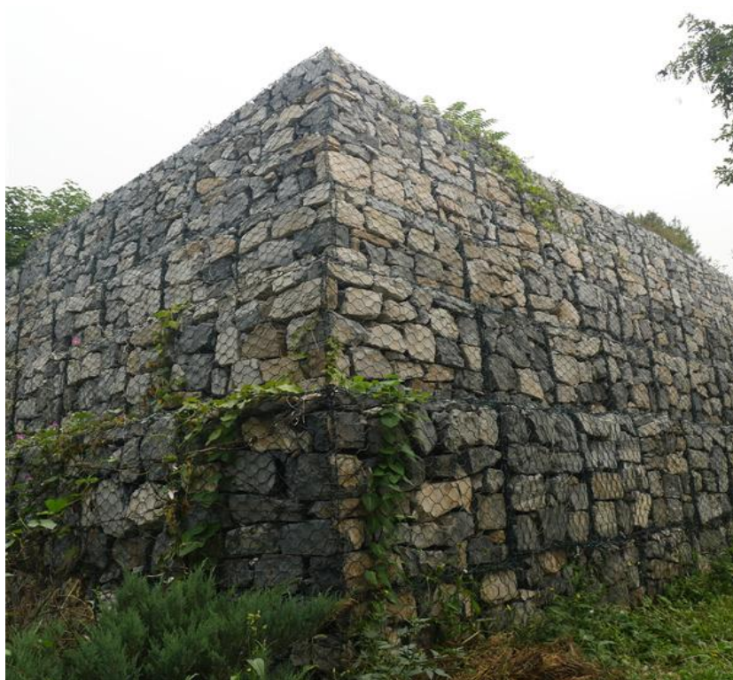
Εικόνα 6: Πέτρινο φράγμα πλημμύρας
