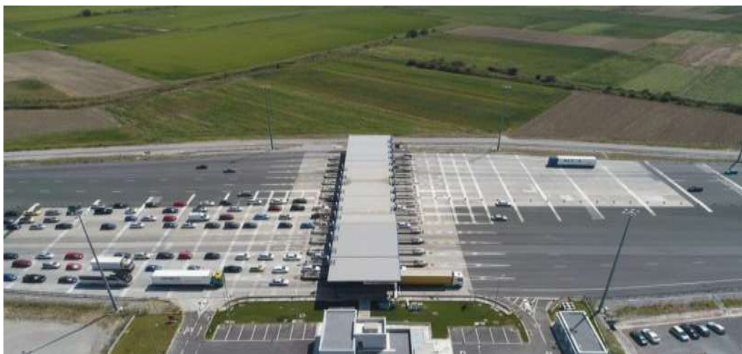
Εικόνα 2.1 Μετωπικός σταθμός διοδίων Κλειδίου
