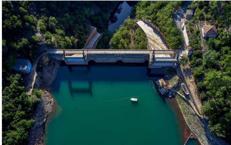
Εικόνα 4.4: Φράγμα Λάδωνα (Αρκαδία), αντηριδωτό, με δύο εκχειλιστές, σήραγγα επίσκεψης και σήραγγα εκτροπής - εκκενωτή πυθμένα
