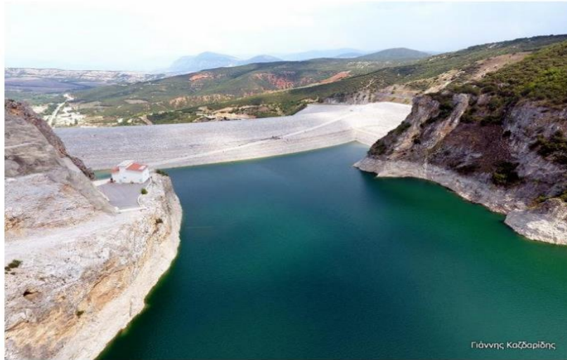
Εικόνα 4.6: Φράγμα Ιλαρίωνα (Αλιάκμονας), χωμάτινο με κεντρικό πυρήνα
