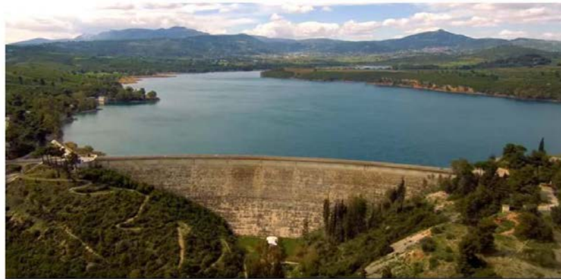
Εικόνα 4.2: Φράγμα Μαραθώνα, βαρύτητας με ελαφρά καμπυλότητα και υπερχειλιστή στο δεξιό αντέρεισμα.
