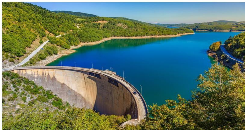
Εικόνα 4.3: Φράγμα Ταυρωπού - Ν. Πλαστήρα (Καρδίτσα), τοξωτό φράγμα, διπλής καμπυλότητας με υπερχειλιστή, σήραγγα επίσκεψης, σήραγγα εκτροπής και δύο εκκενωτές πυθμένα
