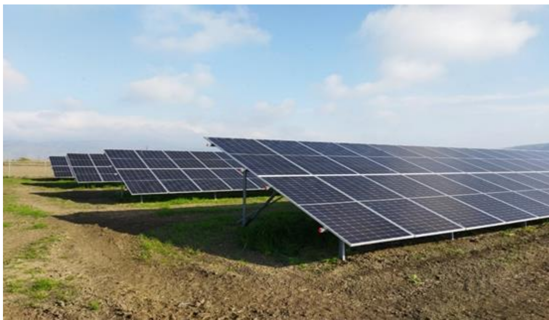
Εικόνα 14: Ενδεικτική απόσταση μεταξύ συστοιχιών προς αποφυγή σκίασης - Φωτογραφία φωτοβολταϊκού σταθμού της εταιρείας Περιβαλλοντολόγοι Energy.
