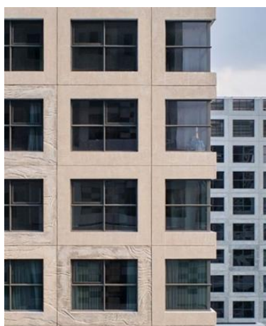
(α) Περιμετρική στήριξη υαλοπινάκων (β) Περίπλοκες μορφές πάνελ
