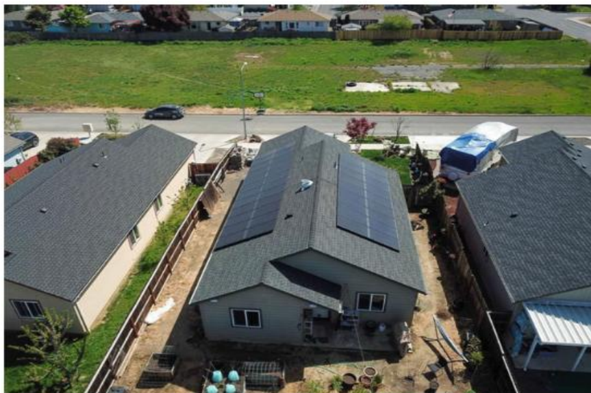
Εικόνα 57 Σύστημα φωτοβολταϊκών πλαισίων στη οροφή [1].
