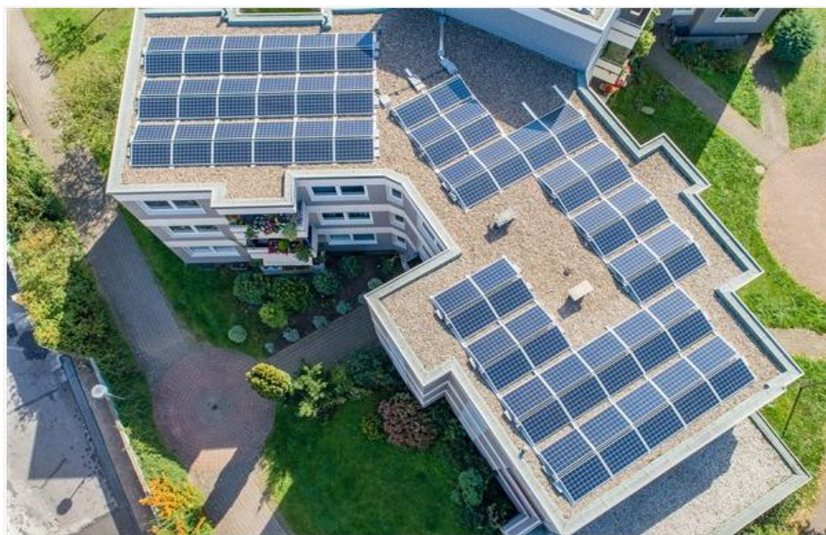
Εικόνα 55 Πάνελ εγκαταστημένα σε δώμα (Σταθερή εγκατάσταση) [1].
