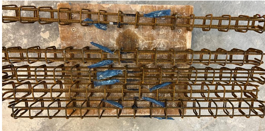
Σχήμα 3.7 Κλωβοί οπλισμού πριν την τοποθέτηση στους ξυλότυπους
