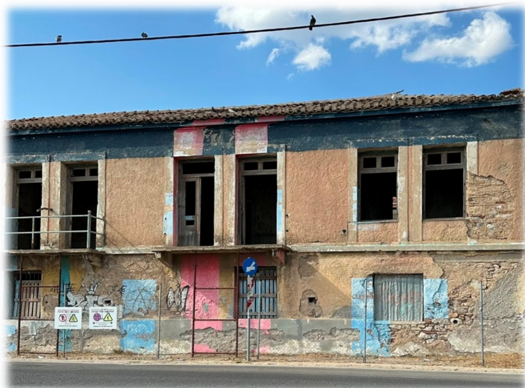
Εικόνα 20. Εγκαταλελειμμένο κτήριο εντός της περιοχής παρέμβασης
