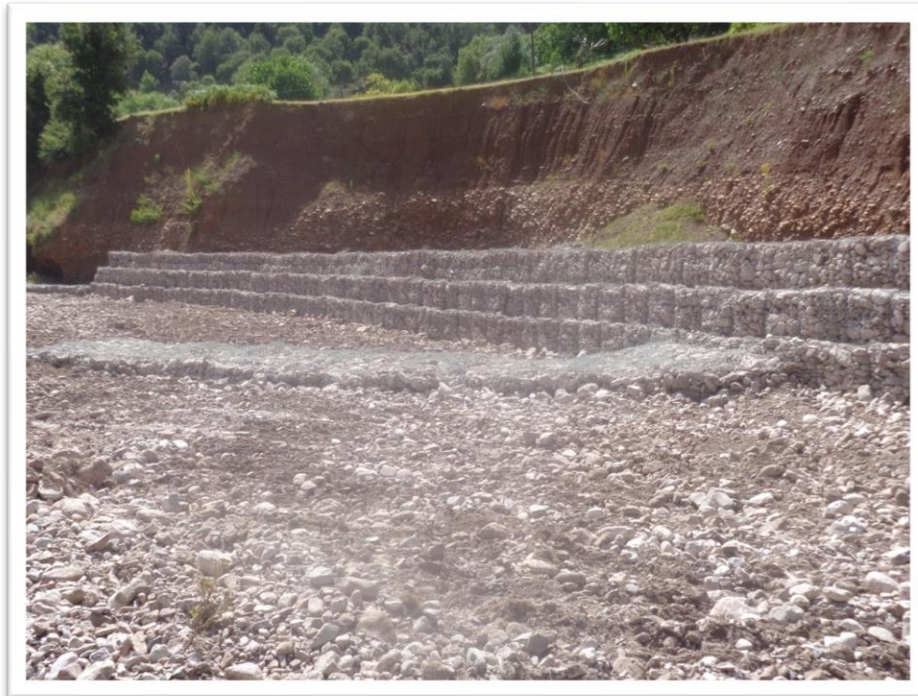
Εικόνα 5.16 Κατασκευή συρματοκιβωτίων επί της οδού Κρέντης – Βαρβαριάδας – Αγράφων Νομού Ευρυτανίας (Πηγή: Προσωπική συλλογή φωτογραφιών Δ. Χριστοδούλου, Αύγουστος 2014).
