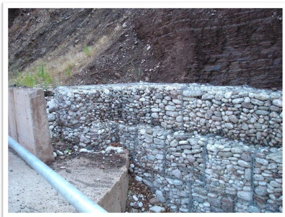
Εικόνα 5.23 Κατασκευή συρματοκιβωτίων επί της οδού Κρέντης – Βαρβαριάδας – Αγράφων Νομού Ευρυτανίας (Πηγή: Προσωπική συλλογή φωτογραφιών Δ. Χριστοδούλου, Αύγουστος 2014).
