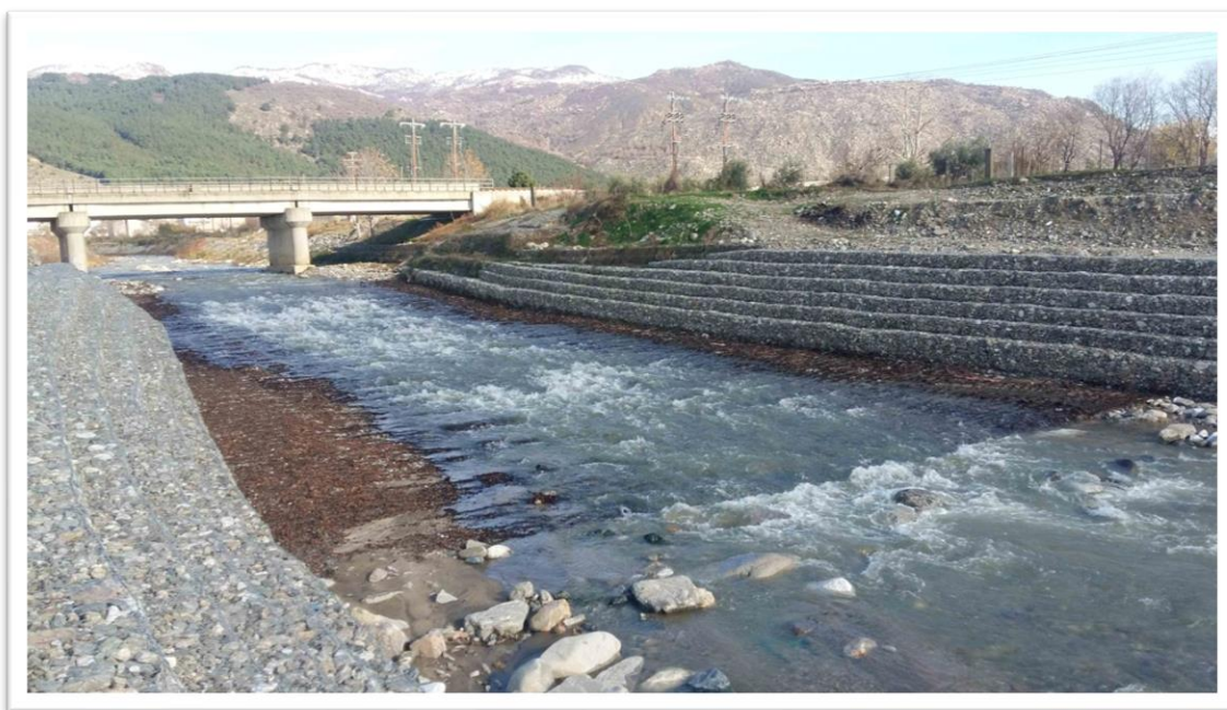
Εικόνα 5.1. Επένδυση πρανών χείμαρρου Κιμμερίων με συρματοκιβώτια (Πηγή: Περιφερειακή Ενότητα Ξάνθης).
