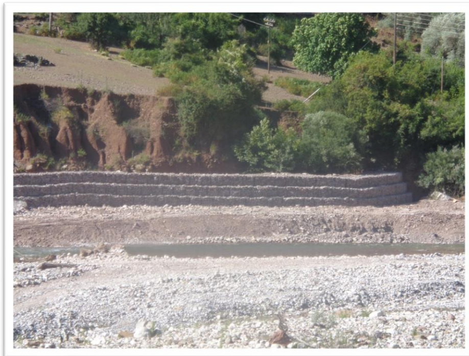
Εικόνα 5.19 Κατασκευή συρματοκιβωτίων επί της οδού Κρέντης – Βαρβαριάδας – Αγράφων Νομού Ευρυτανίας (Πηγή: Προσωπική συλλογή φωτογραφιών Δ. Χριστοδούλου, Αύγουστος 2014).
