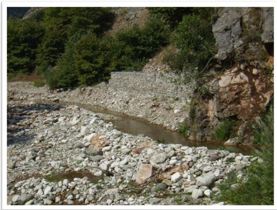
Εικόνα 5.7 Τοίχος αντιστήριξης με συρματοπλεκτα κιβώτια στη γέφυρα Παλαιοκαρνάς ((Κουλουκούρας, 2011)
