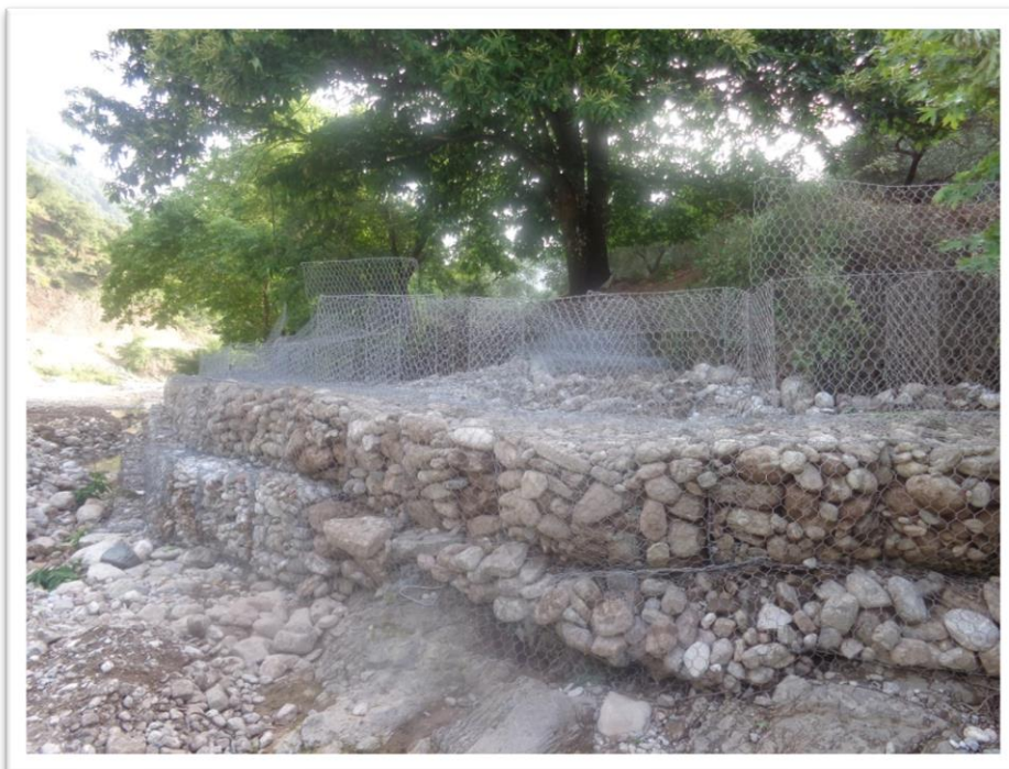
Εικόνα 5.11 Κατασκευή συρματοκιβωτίων επί της οδού Κρέντης – Βαρβαριάδας – Αγράφων Νομού Ευρυτανίας (Πηγή: Προσωπική συλλογή φωτογραφιών Δ. Χριστοδούλου, Αύγουστος 2014).
