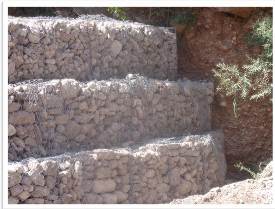
Εικόνα 5.18 Κατασκευή συρματοκιβωτίων επί της οδού Κρέντης – Βαρβαριάδας – Αγράφων Νομού Ευρυτανίας (Πηγή: Προσωπική συλλογή φωτογραφιών Δ. Χριστοδούλου, Αύγουστος 2014).
