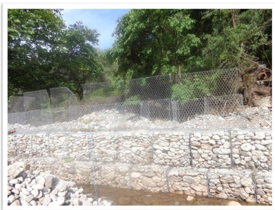
Εικόνα 5.10 Κατασκευή συρματοκιβωτίων επί της οδού Κρέντης – Βαρβαριάδας – Αγράφων Νομού Ευρυτανίας (Πηγή: Προσωπική συλλογή φωτογραφιών Δ. Χριστοδούλου, Αύγουστος 2014).
