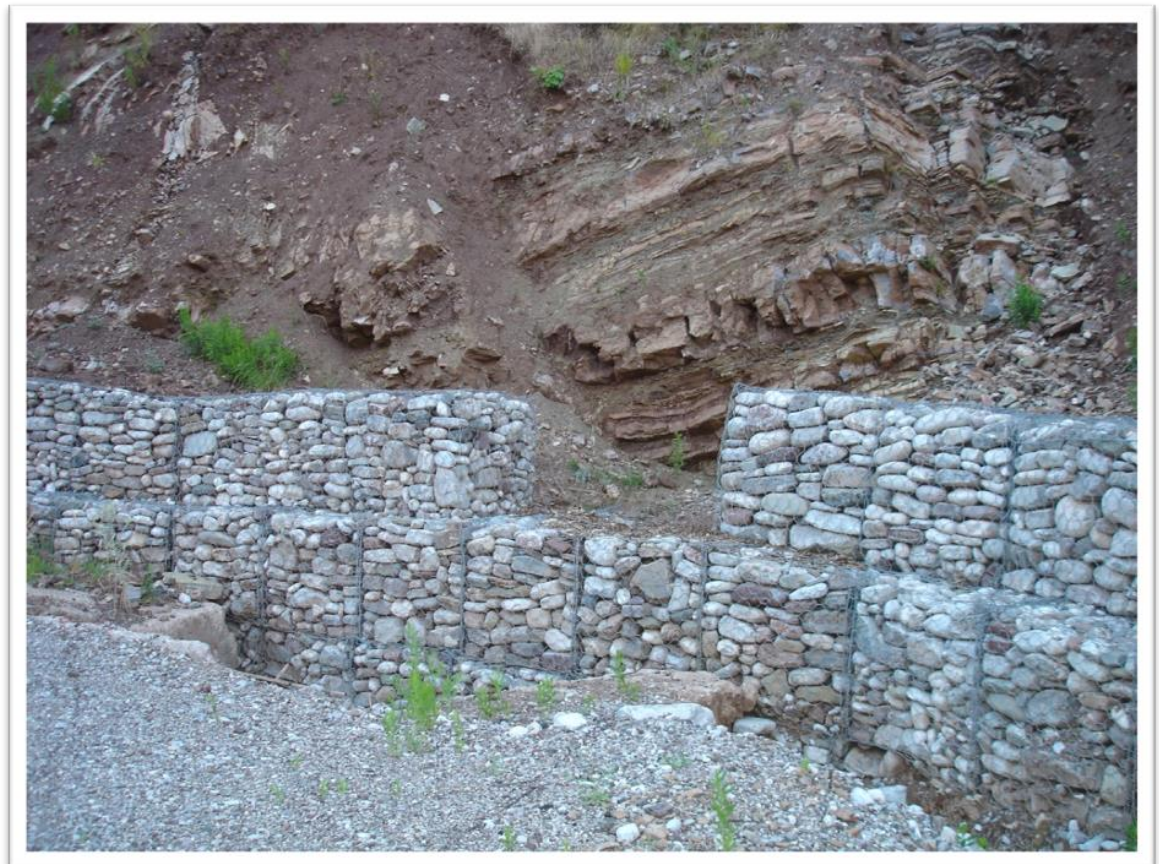
Εικόνα 5.8 Κατασκευή συρματοκιβωτίων επί της οδού Κρέντης – Βαρβαριάδας – Αγράφων Νομού Ευρυτανίας (Πηγή: Προσωπική συλλογή φωτογραφιών Δ. Χριστοδούλου, Αύγουστος 2014).
