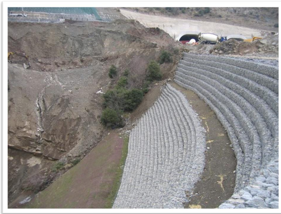
Εικόνα 5.5 Χρήση συρματοκιβωτίων σε επίχωμα (Πηγή: OmikronKappa Consulting)
