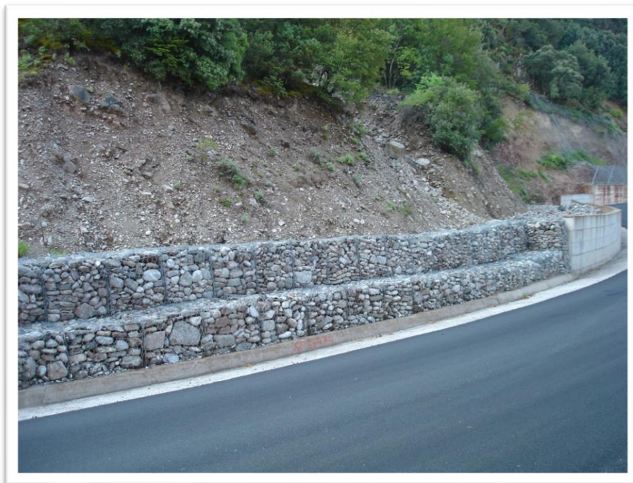
Εικόνα 5.20 Κατασκευή συρματοκιβωτίων επί της οδού Κρέντης – Βαρβαριάδας – Αγράφων Νομού Ευρυτανίας (Πηγή: Προσωπική συλλογή φωτογραφιών Δ. Χριστοδούλου, Αύγουστος 2014).
