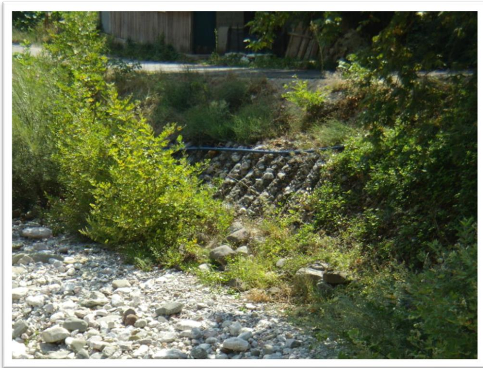
Εικόνα 5.6 Επένδυση πρανών με συρματοπλεκτα κιβώτια στη γέφυρα Παλαιοκαρνάς ((Κουλουκούρας, 2011)
