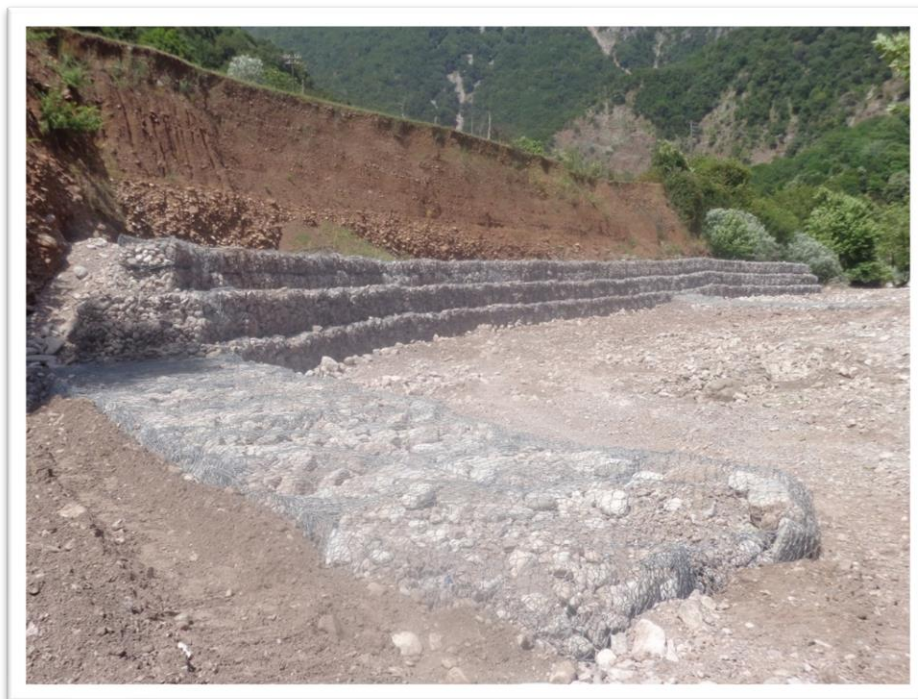
Εικόνα 5.17 Κατασκευή συρματοκιβωτίων επί της οδού Κρέντης – Βαρβαριάδας – Αγράφων Νομού Ευρυτανίας (Πηγή: Προσωπική συλλογή φωτογραφιών Δ. Χριστοδούλου, Αύγουστος 2014).
