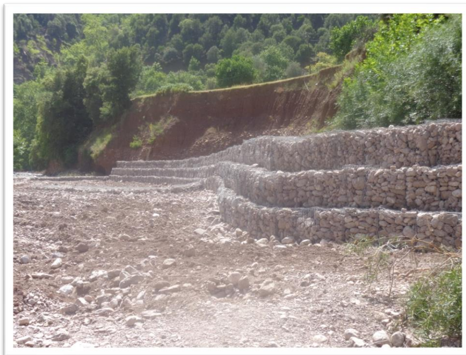
Εικόνα 5.15 Κατασκευή συρματοκιβωτίων επί της οδού Κρέντης – Βαρβαριάδας – Αγράφων Νομού Ευρυτανίας (Πηγή: Προσωπική συλλογή φωτογραφιών Δ. Χριστοδούλου, Αύγουστος 2014).
