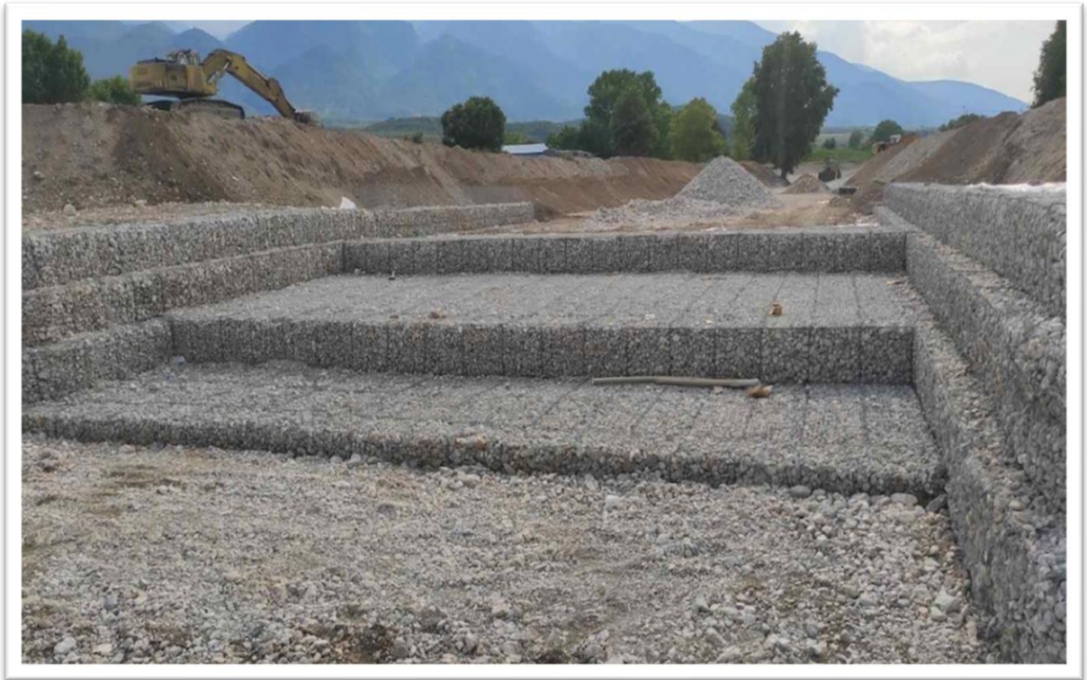
Εικόνα 5.3 Διαμόρφωση κοίτης ρέματος με χρήση συρματοκιβωτίων (Πηγή: Maccaferri Ελλάς)
