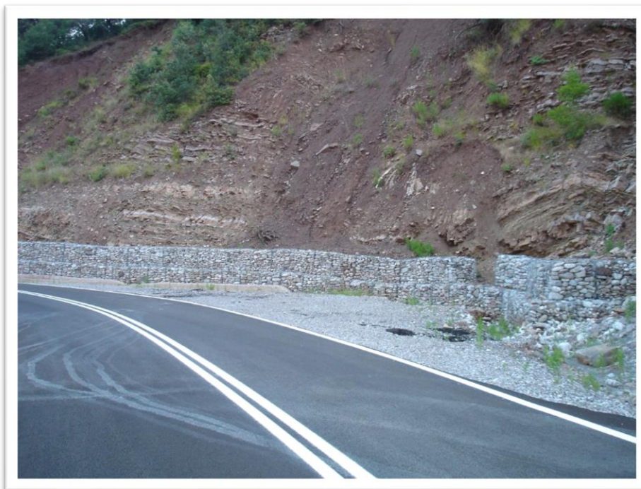
Εικόνα 5.9 Κατασκευή συρματοκιβωτίων επί της οδού Κρέντης – Βαρβαριάδας – Αγράφων Νομού Ευρυτανίας (Πηγή: Προσωπική συλλογή φωτογραφιών Δ. Χριστοδούλου, Αύγουστος 2014).
