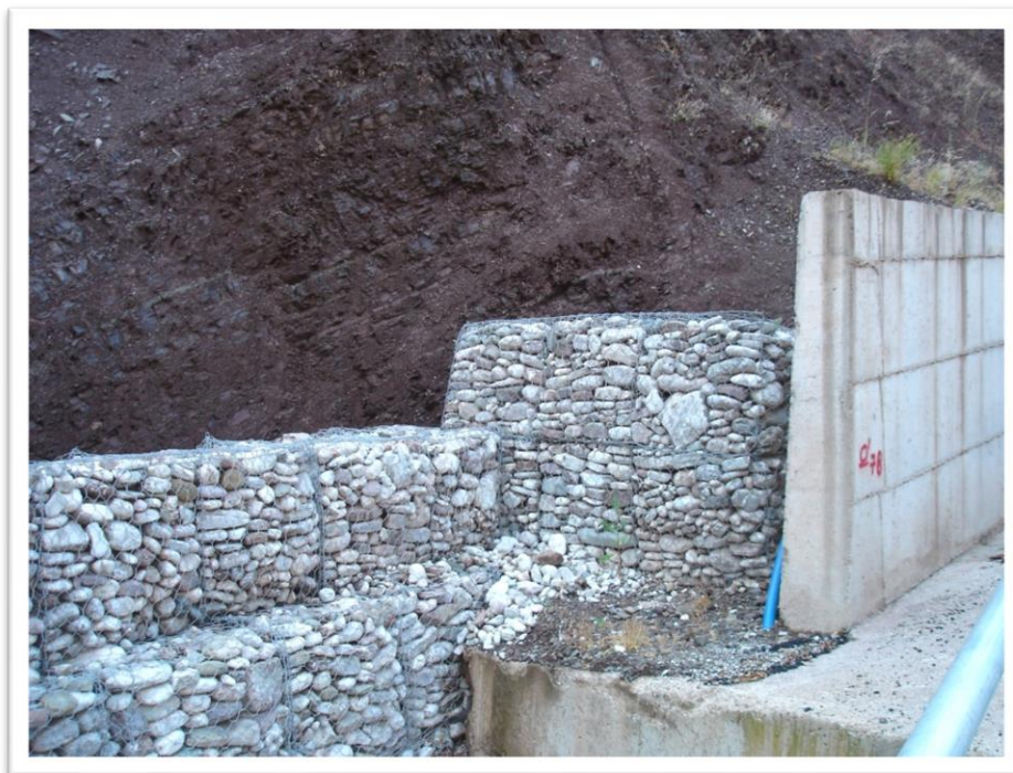
Εικόνα 5.22 Κατασκευή συρματοκιβωτίων επί της οδού Κρέντης – Βαρβαριάδας – Αγράφων Νομού Ευρυτανίας (Πηγή: Προσωπική συλλογή φωτογραφιών Δ. Χριστοδούλου, Αύγουστος 2014).
