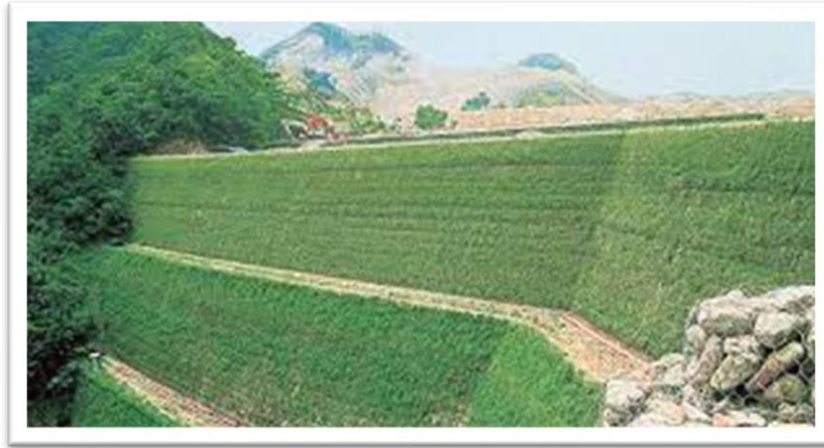
Εικόνα 6.1 Κάλυψη βλάστησης στα συρματοκιβώτια
