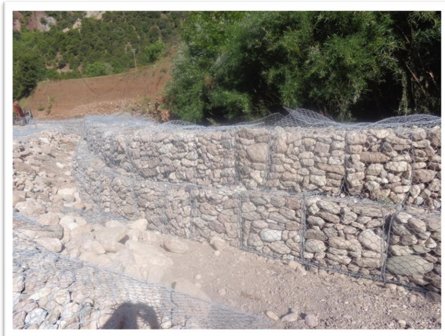
Εικόνα 5.14 Κατασκευή συρματοκιβωτίων επί της οδού Κρέντης – Βαρβαριάδας – Αγράφων Νομού Ευρυτανίας (Πηγή: Προσωπική συλλογή φωτογραφιών Δ. Χριστοδούλου, Αύγουστος 2014).
