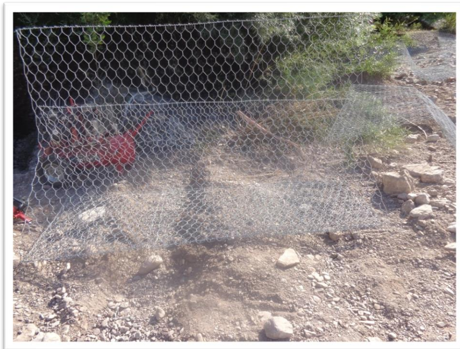
Εικόνα 5.13 Κατασκευή συρματοκιβωτίων επί της οδού Κρέντης – Βαρβαριάδας – Αγράφων Νομού Ευρυτανίας (Πηγή: Προσωπική συλλογή φωτογραφιών Δ. Χριστοδούλου, Αύγουστος 2014).
