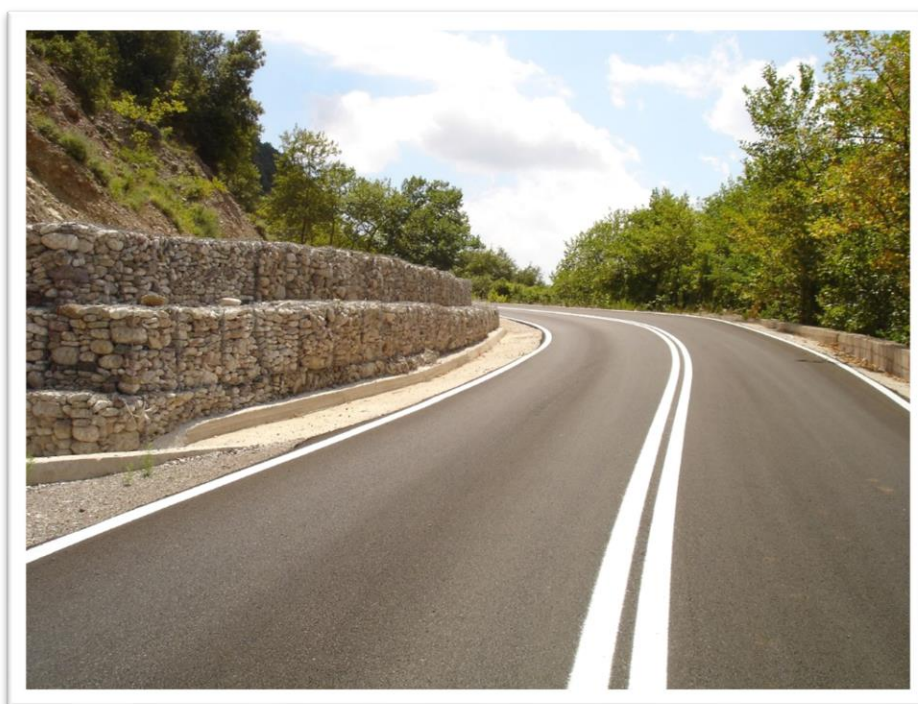
Εικόνα 5.24 Κατασκευή συρματοκιβωτίων επί της οδού Κρέντης – Βαρβαριάδας – Αγράφων Νομού Ευρυτανίας (Πηγή: Προσωπική συλλογή φωτογραφιών Δ. Χριστοδούλου, Αύγουστος 2014).
