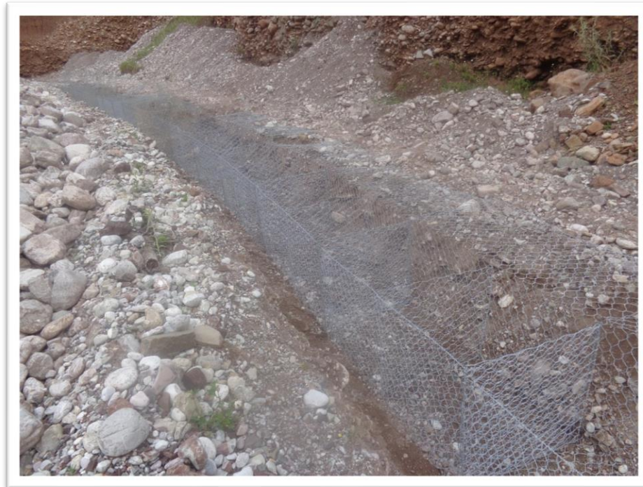
Εικόνα 5.12 Κατασκευή συρματοκιβωτίων επί της οδού Κρέντης – Βαρβαριάδας – Αγράφων Νομού Ευρυτανίας (Πηγή: Προσωπική συλλογή φωτογραφιών Δ. Χριστοδούλου, Αύγουστος 2014).
