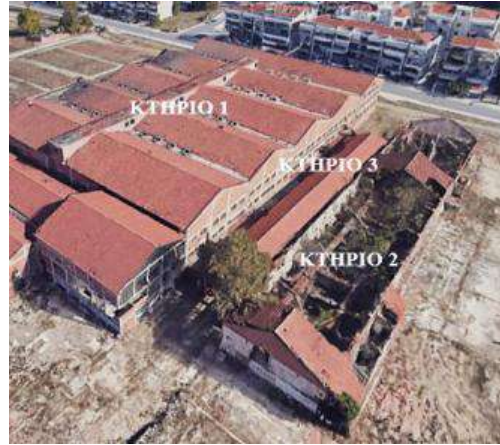
Εικόνα 55: Τα κτήρια 1, 2 & 3 της περιοχής μελέτης Πηγή: Google Earth, Ιδία Επεξεργασία
