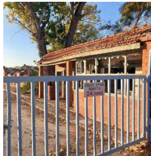
Εικόνα 58: Το κτήριο 16 Πηγή: Προσωπικό Αρχείο
