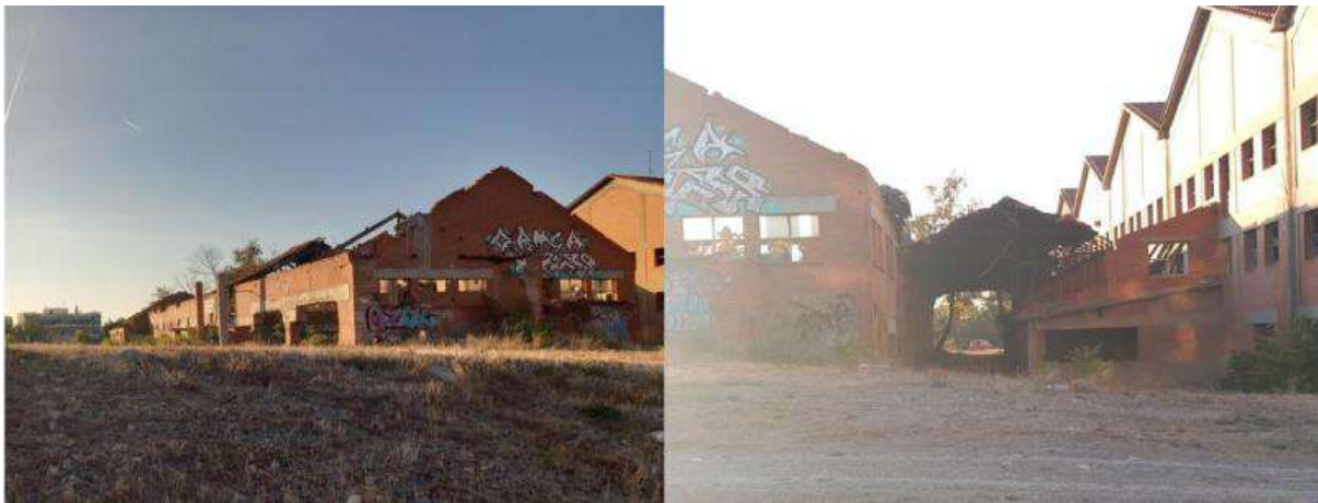
Εικόνα 56: Το κτήριο 2 αριστερά και το κτήριο 3 δεξιά Πηγή: Προσωπικό Αρχείο
