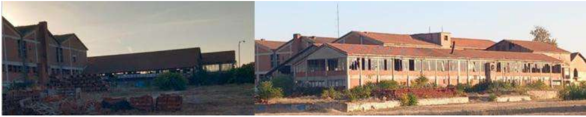
Εικόνα 57: Το Κτήριο 9 αριστερά και το Κτήριο 10 δεξιά Πηγή: Προσωπικό Αρχείο
