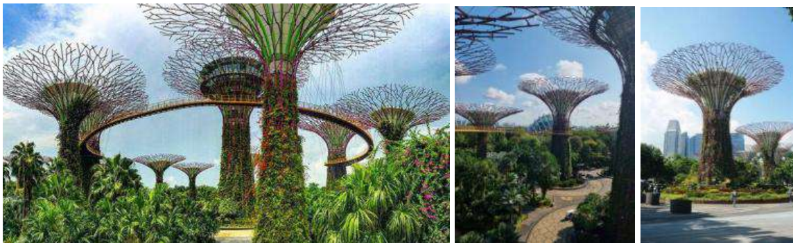
Εικόνα 97: Τα φωτοβολταϊκά δέντρα (solar trees), που βρίσκονται στο εμβληματικό πάρκο της Σιγκαπούρης Πηγή: https://gr.pinterest.com/pin/848998967224926646/
