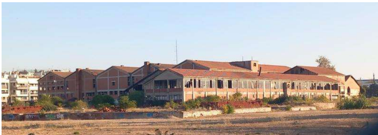
Η βόρειο - δυτική όψη της πρώην βιομηχανίας Αλλατίνη
