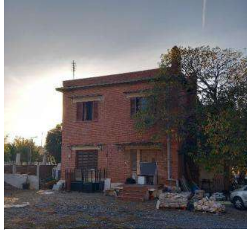
Εικόνα 59: Το Κτήριο 20 Πηγή: Προσωπικό Αρχείο
