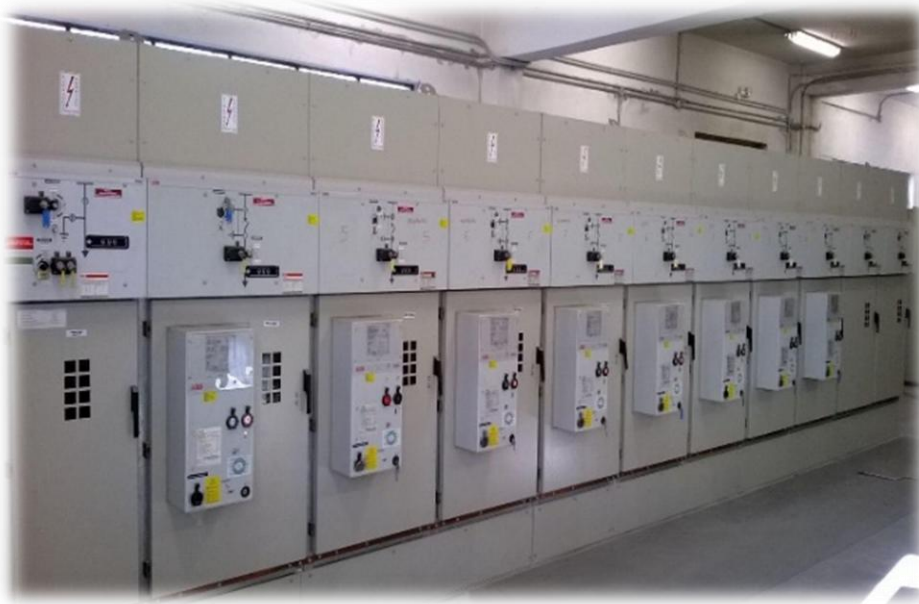
Σχήμα 1.2.: Πίνακες μέσης τάσης- Υποσταθμοί μέσης τάσης [5].
