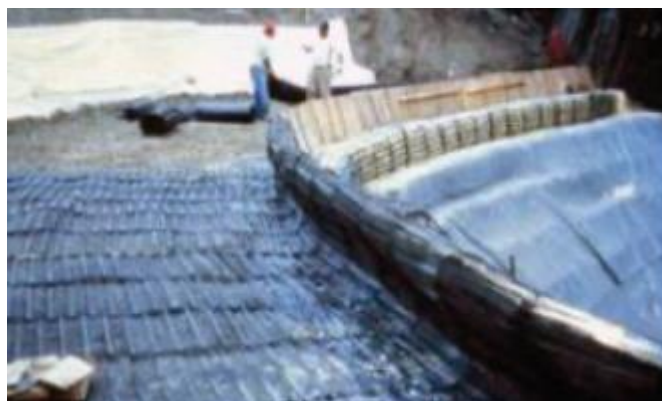
Εικόνα 25. Παράδειγμα αποκατάστασης πρανού με όπλιση της διαμορφωμένης με επίχωση παρειάς του (IGS, 2023c)
