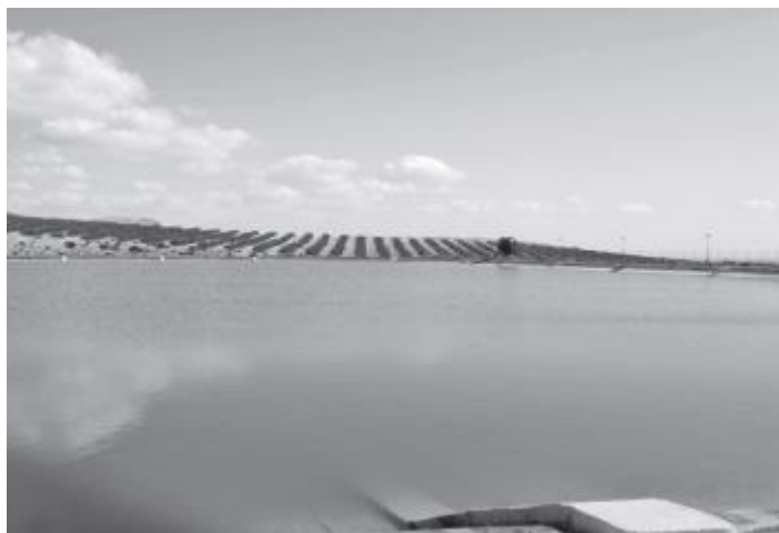
Εικόνα 26. Γεωμεμβράνη HDPE εγκατεστημένη στον ταμιευτήρα La Mericana (Jarandilla de la Vera-Cáceres-Ισπανία) (Touze, 2022).
