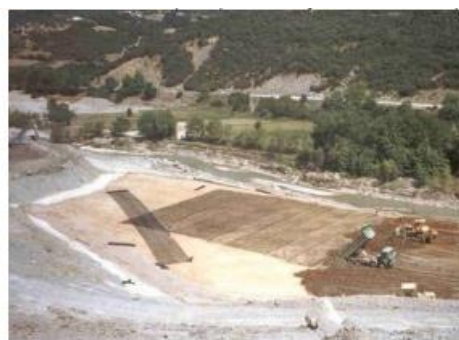
Εικόνα 28. Φωτογραφίες που ελήφθησαν κατά τη διάρκεια της κατασκευής ενισχυμένου επιχώματος κατά μήκος της Εγνατίας οδού (βλέπε επίσης Σχήμα 2). α) Εκσκαφές θεμελίωσης για την αγκύρωση του επιχώματος - β) τοποθέτηση γεωπλεγμάτων και διαδικασία επίχωσης (Fikiris, 2008)
