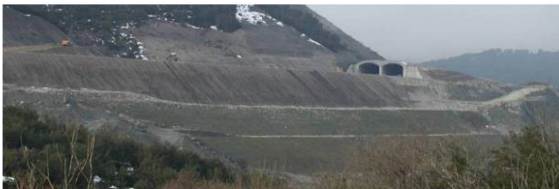
Εικόνα 29. Άποψη της τελικής γεωμετρίας του ενισχυμένου επιχώματος (βλέπε επίσης Σχήμα 2). Έναρξη της ανάπτυξης της βλάστησης. (Fikiris, 2008)
