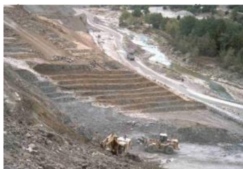
Εικόνα 28. Φωτογραφίες που ελήφθησαν κατά τη διάρκεια της κατασκευής ενισχυμένου επιχώματος κατά μήκος της Εγνατίας οδού (βλέπε επίσης Σχήμα 2). α) Εκσκαφές θεμελίωσης για την αγκύρωση του επιχώματος - β) τοποθέτηση γεωπλεγμάτων και διαδικασία επίχωσης (Fikiris, 2008)
