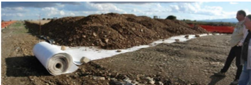
Εικόνα 23. Τοποθέτηση γεωσύνθετου αποστράγγισης στη βάση του σιδηροδρομικού επιχώματος. Σε αυτή την περίπτωση το GCD τοποθετείται κατά μήκος του επιχώματος (IGS, 2023b)
