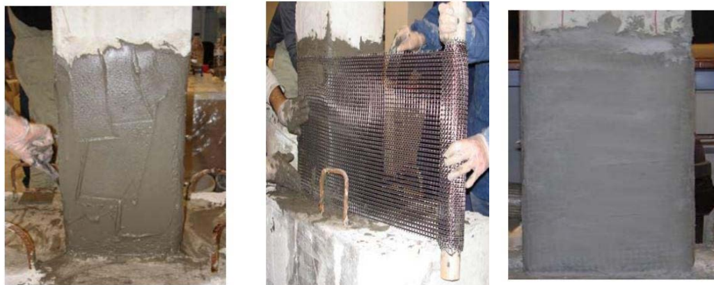
Σχήμα 2.9 i)Επάλειψη υποστρώματος με κονίαμα ii)Περιτύλιξη Πλέγματος iii)Τελική επίστρωση με τσιμεντοκονία (Ζυγούρης Κ., 2007).
