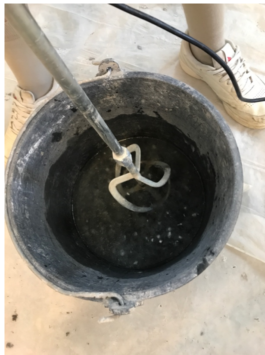
Σχήμα 3.12 Ανάμειξη υλικών σε αναδευτήρα.
