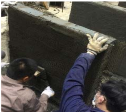
Σχήμα 2.8 Εφαρμογή σύνθετου υλικού για ενίσχυση σε τοιχοποιία (Xuan Wang et al., 2019).
