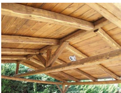
Εικόνα 2.6: Πελεκητή ξυλεία Λάρικας (Αριστερά), Κατασκευή στέγης με πελεκητή ξυλεία (Δεξιά).
