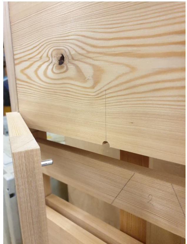
Εικόνα 5.36: Τρύπα στο πίσω μέρος της επιφάνειας για να μπαίνει χωνευτά ο πείρος.
