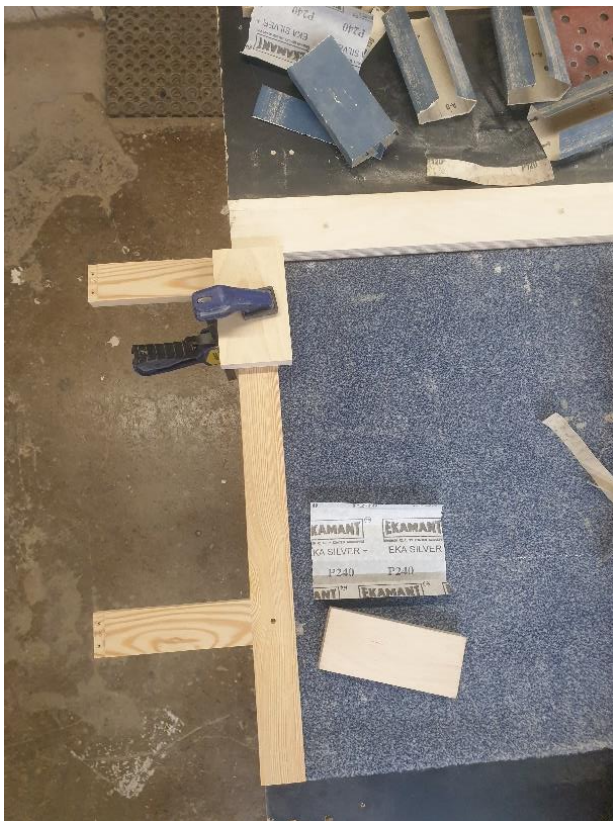
Εικόνα 5.53: Σπάσιμο των γωνιών με γυαλόχαρτο 240p I.
