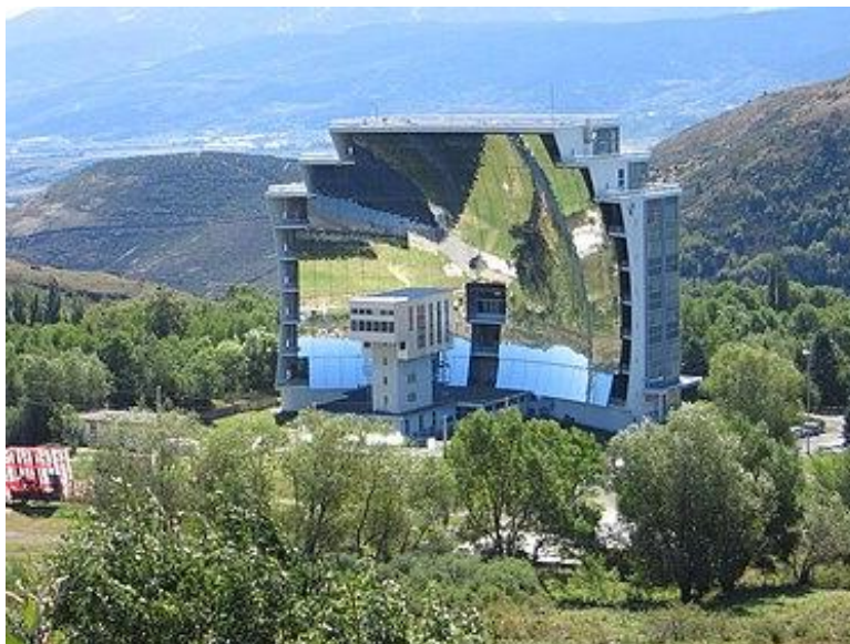
Εικόνα 9 Ηλιακός συλλέκτης με κάτοπτρα στη Γαλλία. Ο συγκεκριμένος συλλέκτης μπορεί να φτάσει υψηλές θερμοκρασίες (μέχρι και 3.800 βαθμών Κελσίου). Εφαρμογή ηλιοθερμικών συστημάτων στη βιομηχανία (commons.wikimedia.org/wiki/File:Four-solaire-odeillo-02.jpg)
