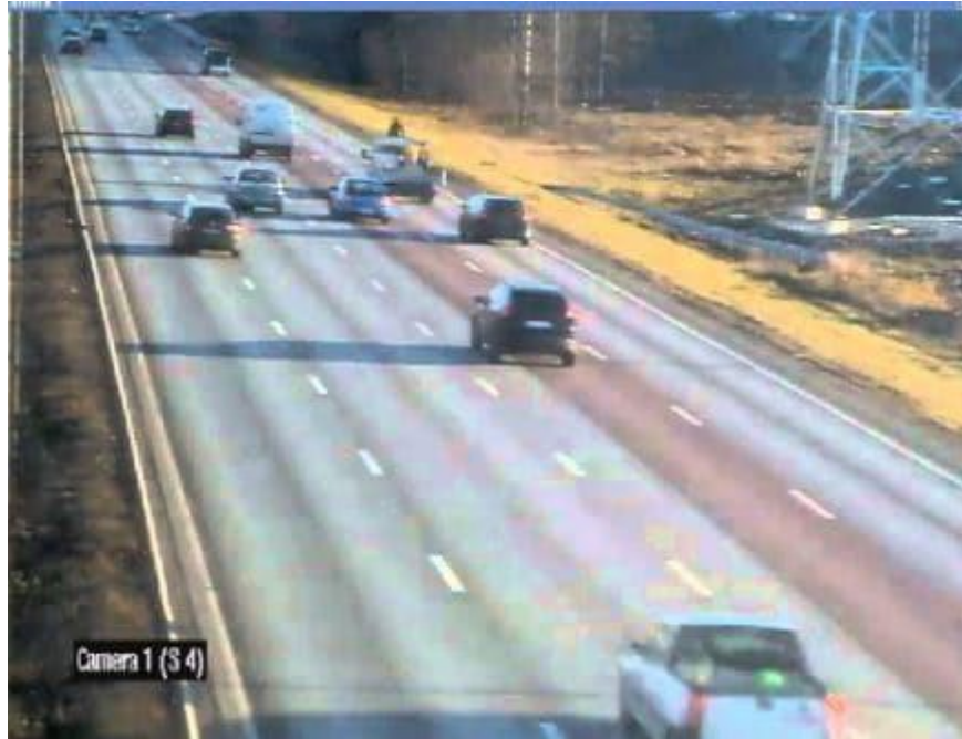
Εικόνα 4: Αυτόματη ανίχνευση περιστατικών (AID) πεζών στον αυτοκινητόδρομο (πηγή: The constructor, building ideas ) [21]
