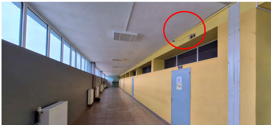
Εικόνα 4.5 : Η θέση του σταθμού 21 στο 2 ο κτήριο.
