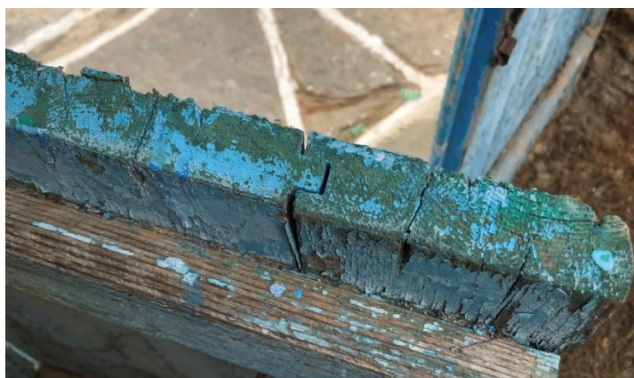
Εικ. 51. Συνδεσμολογία φύλλου πόρτας (σύνδεσμος πλάτους - ξεμορσαριστός).
