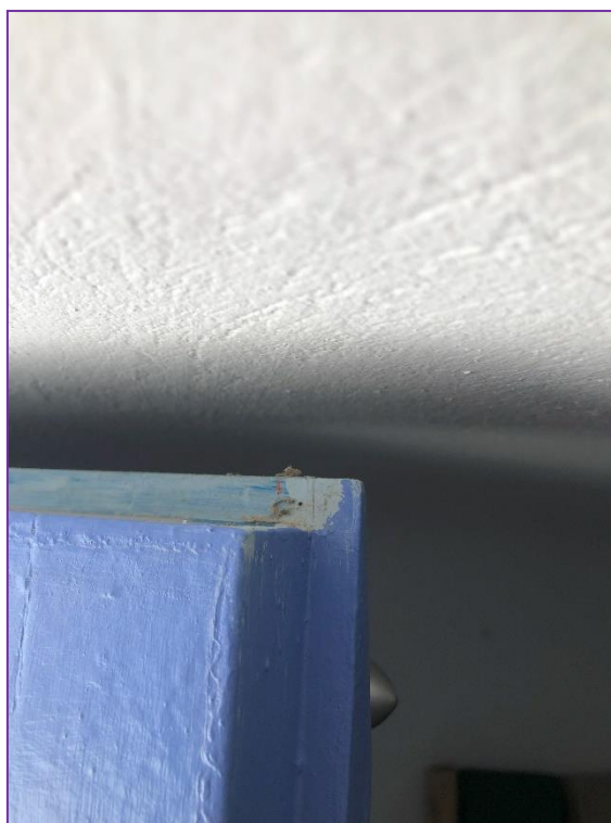
Εικ. 33. Πατούρα μπόϊ τραβέρσας για τη σωστή εφαρμογή της πόρτας στην κάσα.
