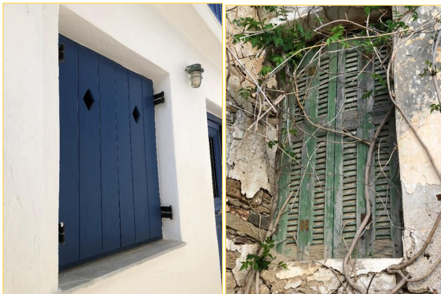
Εικ. 4-5. Κυκλαδίτικα κουφώματα. Αριστερά ένα καινούργιο παντζούρι και δεξιά ένα παλιό με εμφανή τα σημάδια αλλοίωσης από το πέρασμα του χρόνου.
