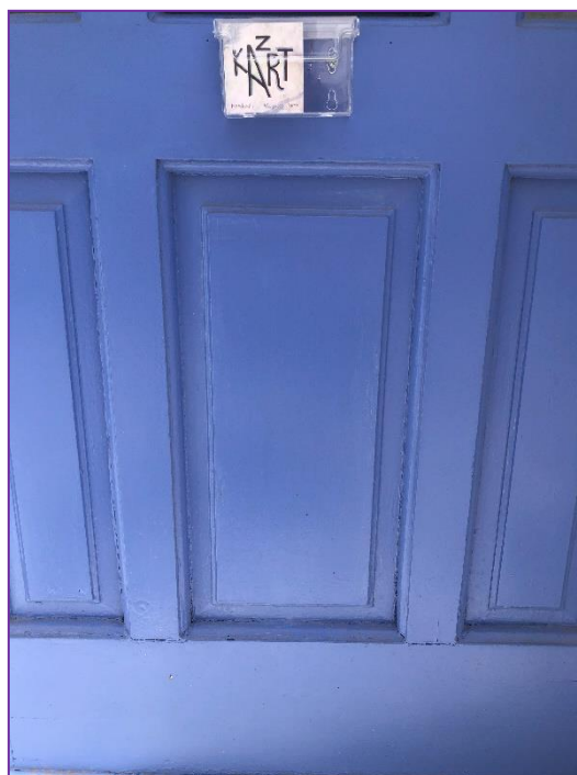
Εικ. 32. Μεγάλος ταμπλάς και μπόϊ συνδετικό μεταξύ των ταμπλάδων.
