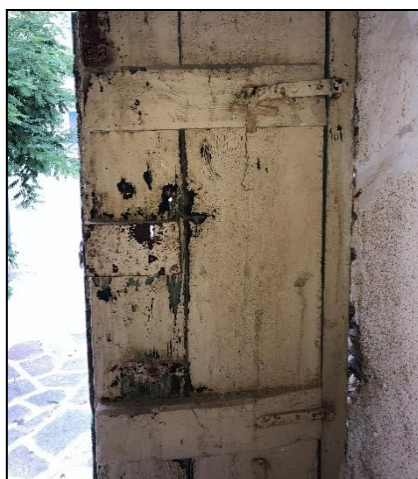
Εικ. 71. Στοιχείο συγκράτησης μεγάλων στοιχείων φύλλου πόρτας.
