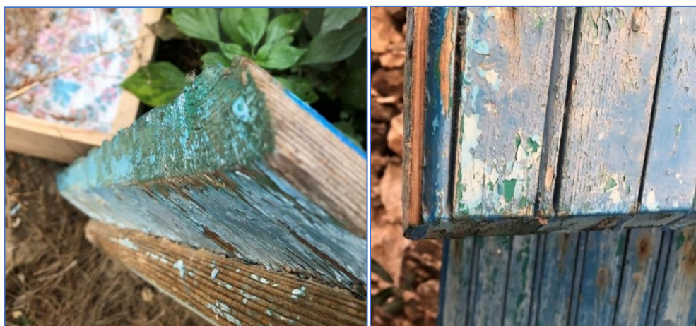
Εικ. 53. Κοπή 45° μοιρών στα φύλλα για σωστή λειτουργία πόρτας.
