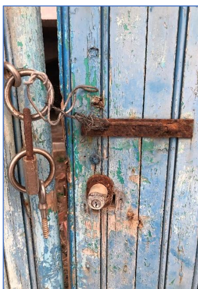
Εικ. 48. Η εξωτερική πλευρά της πόρτας. Διακρίνονται το χερούλι και η υποδοχή για το κλειδί.
