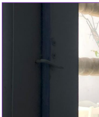
Εικ. 29. Μικρό μεταλλικό αντικείμενο για την συγκράτηση του παραθύρου.
