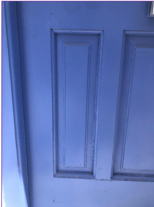
Εικ. 31. Μικρός ταμπλάς και μπόϊ συνδετικό μεταξύ των ταμπλάδων.
