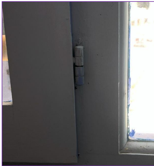
Εικ. 30. Μηχανισμός άνοιγμα-κλείσιμο παραθύρου.
