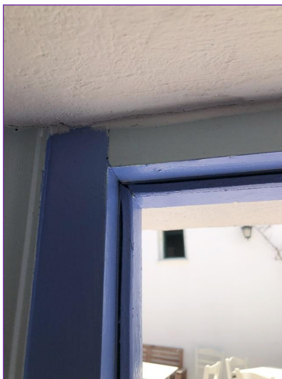
Εικ. 25. Σύνδεσμος κάσας.
