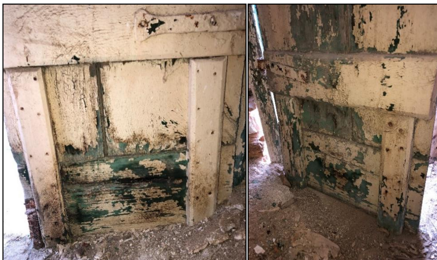
Εικ. 70. Στοιχείο συγκράτησης κάτω μέρους φύλλου πόρτας μαζί με το μικρό στοιχείο.
