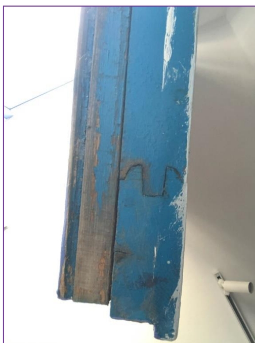
Εικ. 34. Πατούρα μπόϊ τραβέρσας (πατούρα 92' από το εργοστάσιο κουφωμάτων της Πάρου ΕΧΠΑ).
