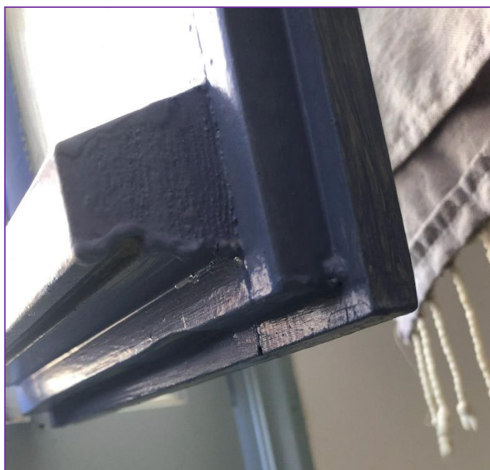
Εικ. 40. Τζαμιλίκι με στοιχείο για απομάκρυνση νερού.
