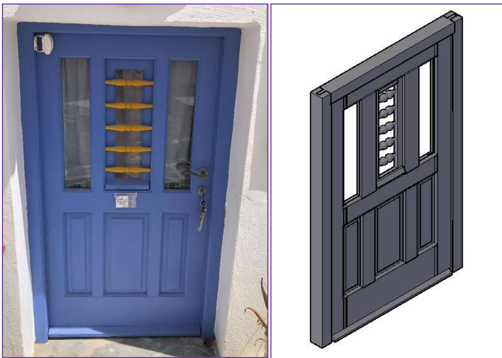
Εικ. 22 - Σχ. 1. Παραδοσιακή πόρτα Πάρου με торναριστά στοιχεία.
