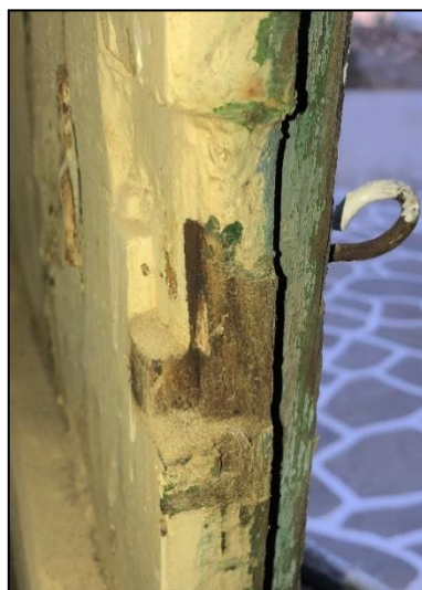
Εικ. 67. Αλλιωμένο σκάψιμο πόρτας για την κλειδαριά.
