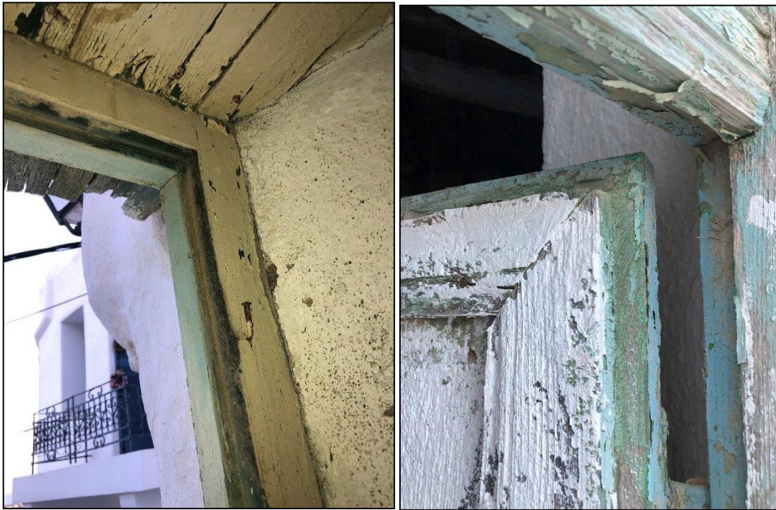
Εικ. 69. Συνδεσμολογία επάνου και κάτω οριζόντιων με κάθετων στοιχείων κάσας.
