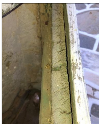
Εικ. 72. Ξεμορσαριστός σύνδεσμος πλάτους φύλλων πόρτας.
