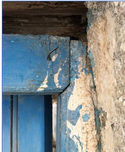
Εικ. 50. Συνδεσμολογία κάσας (εσωτερική πλευρά).
