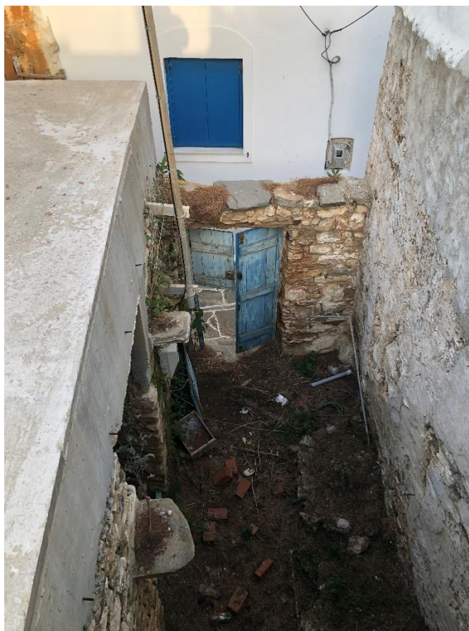
Εικ. 43. Περιβάλλοντας χώρος πόρτας.
