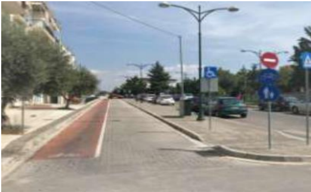
Εικόνα 19 : Οδός Γερολύμπου –ποδηλατόδρομος
