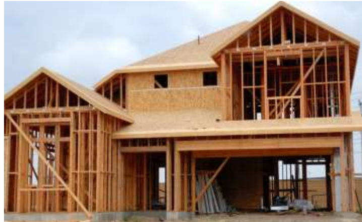
Εικόνα 12: Παράδειγμα σύγχρονης κατασκευής με ξύλινο σκελετό στις Η.Π.Α.. Έντονη χρήση OSB στην τοιχοποιία. (Πηγή: Σκαρβέλης, 2023)
