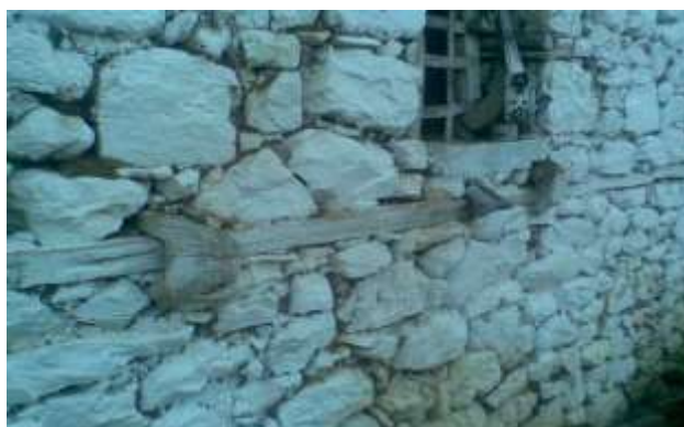
Εικόνα 8: Ξυλοδεσιά σε σπίτι στον Πύργο Ηλείας (περαστή μέσα από τα οριζόντια δοκάρια) (Πηγή: Σκαρβέλης, 2023)
