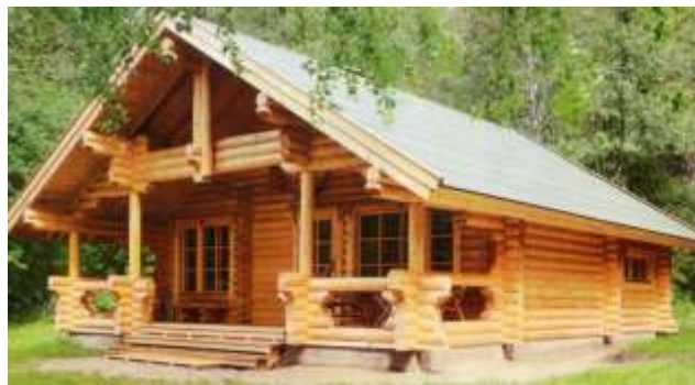
Εικόνα 9: Σύγχρονο κορμόσπιτο με οριζόντια τοποθέτηση κορμών και κατεργασμένα κορμίδια (Πηγή: Σκαρβέλης, 2023)
