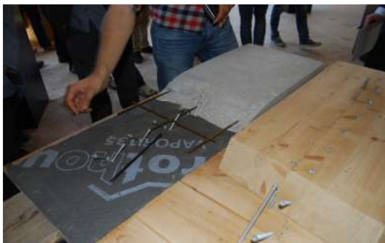
Εικόνα 2: Παράδειγμα σύγχρονου τρόπου ενίσχυσης παλαιού δαπέδου με ελαφρομπετόν, πλέγμα και λεπτή ξύλινη επικάλυψη (φωτ.: Μ. Σκαρβέλης).
