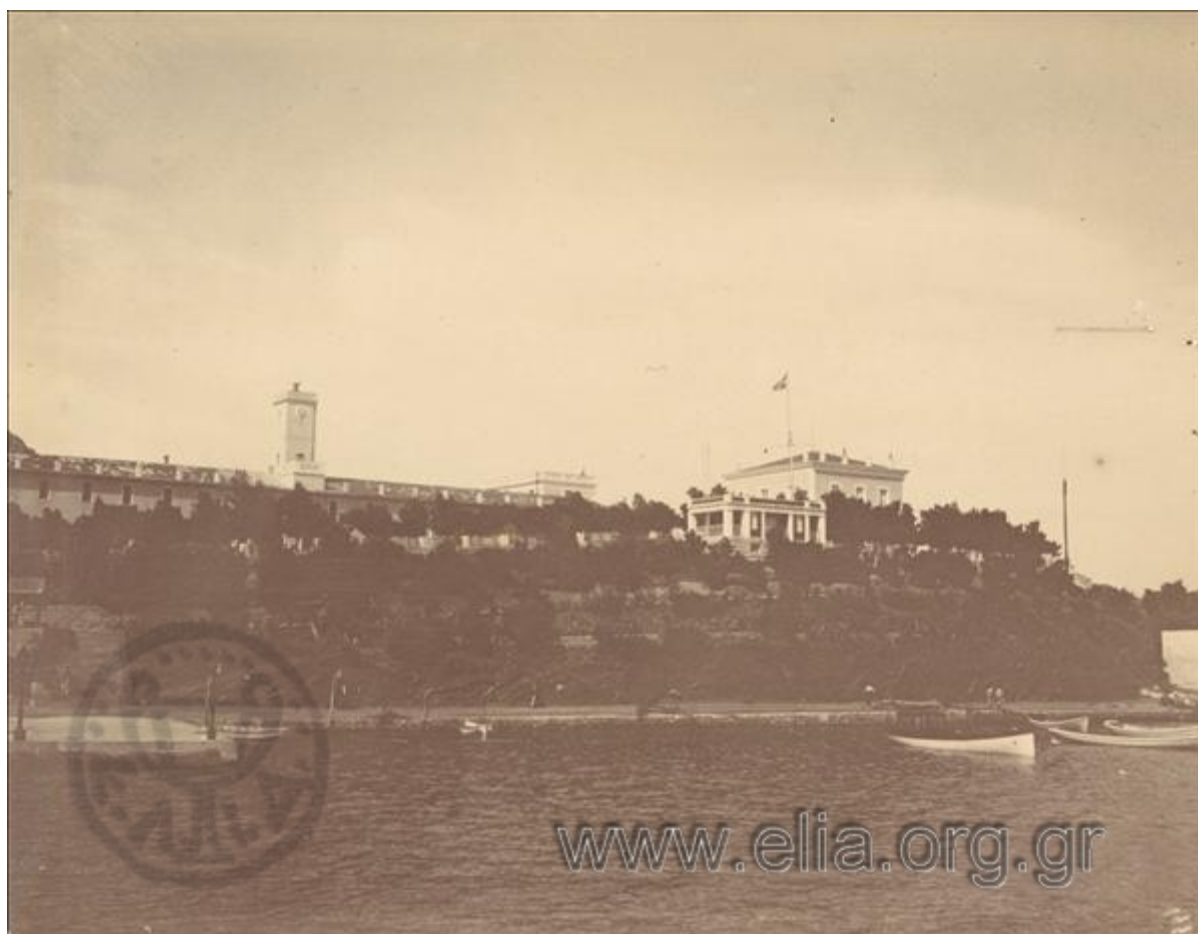
Εικόνα 11: Ο Ναύσταθμός Σαλαμίνας γύρω στο 1902-03. Ο λόφος του Διοικητηρίου Διακρίνεται δεξιά η οικία του διοικητού η κεντρική είσοδος με το περιστύλιο λίγο αριστερότερα η περιτείχιση και ο πύργος με το ρολόι (Πηγή: Ψηφιοποιημένες συλλογές ΕΛΙΑ eliaserver.elia.org.gr:8080 αριθμός τεκμηρίου L307.022)
