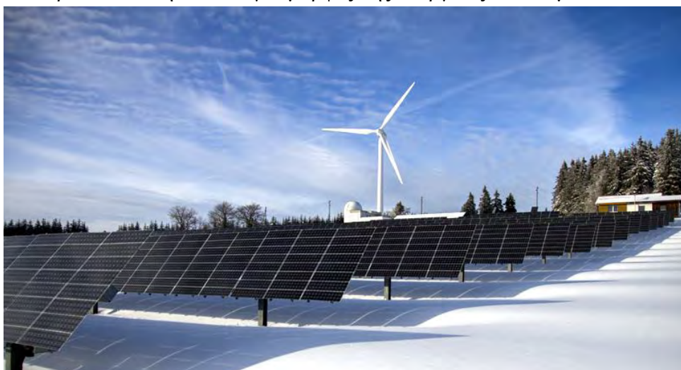
Εικόνα 43. Εγκατάσταση φωτοβολταϊκών συστημάτων και ανανεώσιμων πηγών ενέργειας στα χιονοδρομικά κέντρα
