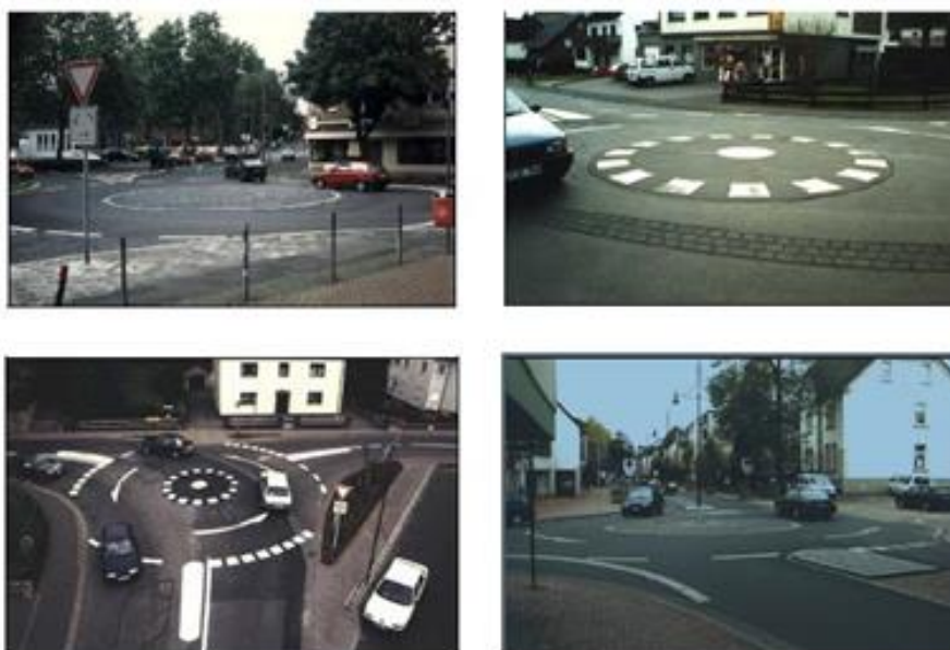
Εικόνα 4-2: Κομβίδια με κεντρική νησίδα πλήρως διελεύσιμη από φορτηγά
