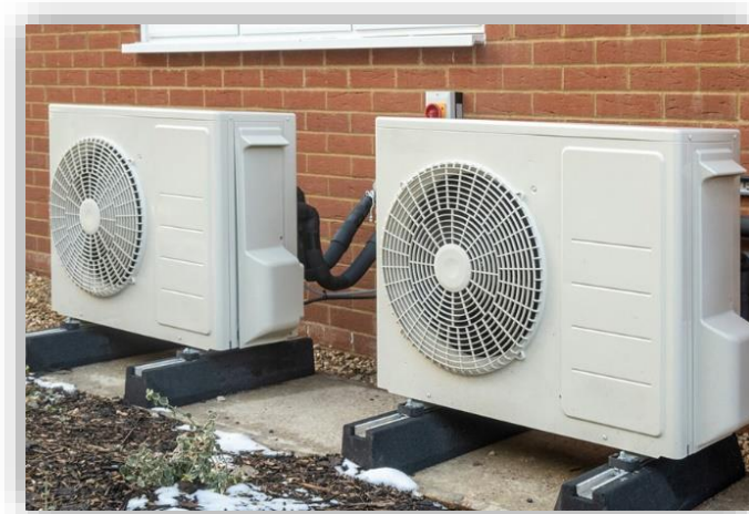
Εικόνα 6-1 Εξωτερική μονάδα μιας τυπικής αντλίας θερμότητας [8]
