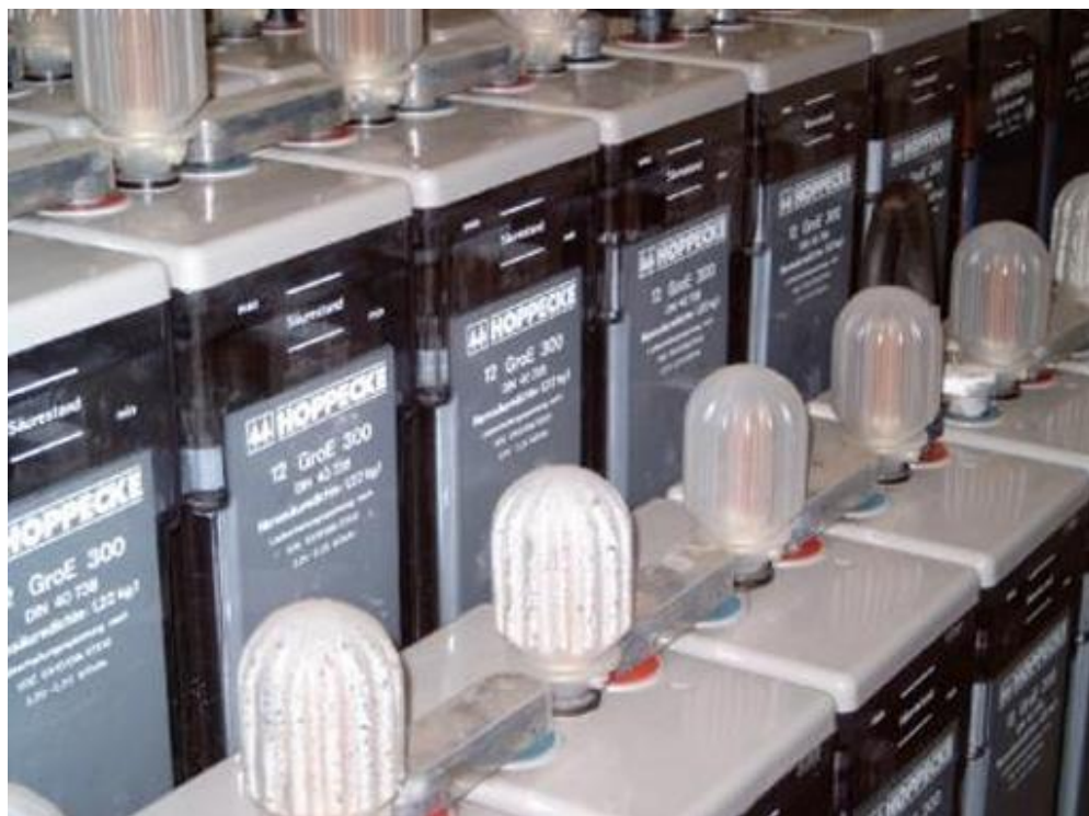
Εικόνα 19: Σύστημα καταλύτη ανασυνδυασμού του νερού [26].
