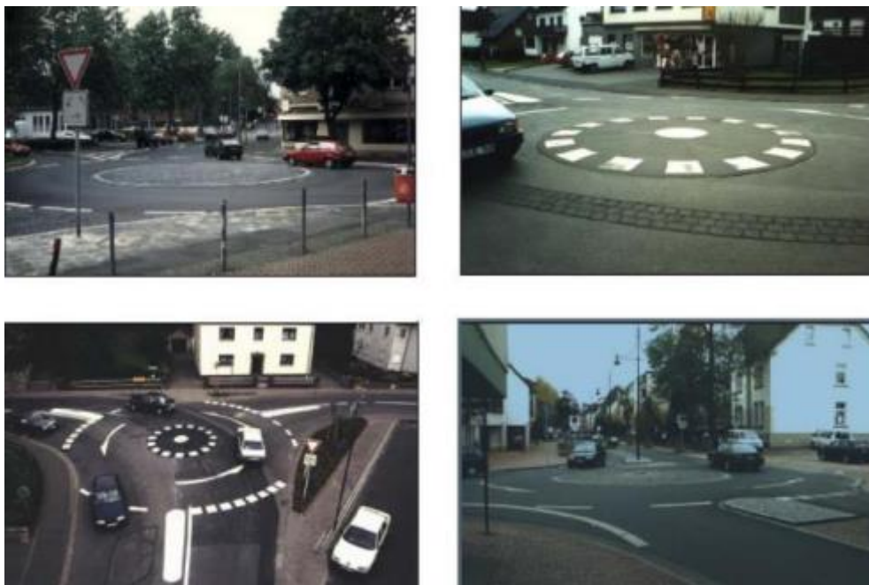
Εικόνα 10: Κομβίδια με κεντρική νησίδα πλήρως διελεύσιμη από φορτηγά
